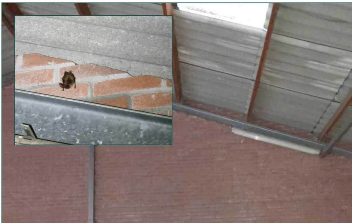
Figuur 3.9 Aanwezig zomerverblijfplaats van gewone grootoorvleermuis in de open kapschuur.
