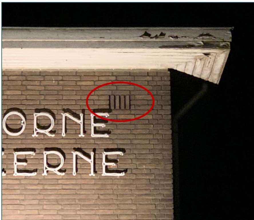
Figuur 3.3 Kraamverblijfplaats van de gewone dwergvleermuis is aangetroffen ter hoogte van de ventilatieroosters (rood omkaderd).
