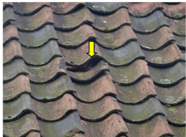
Figuur 6.2 Ruimte tussen losliggende dakpannen, geschikt voor huismus en vleermuis.
