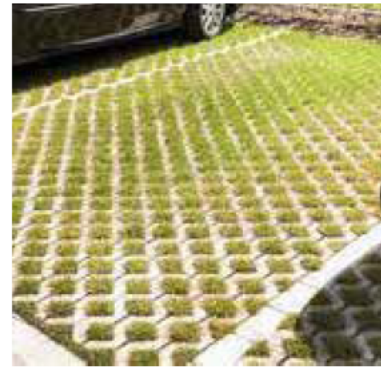
Nieuw grasbeton als inrit
