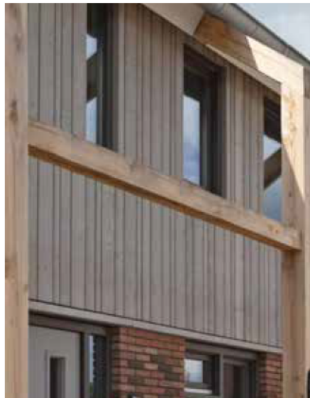
gevel met verticale houten bekleding en metselwerk, met een houten constructiekader.
