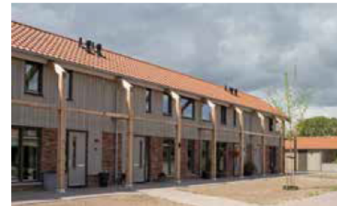
Rijwoningen met kleinschaligheid door middel van houten constructie
