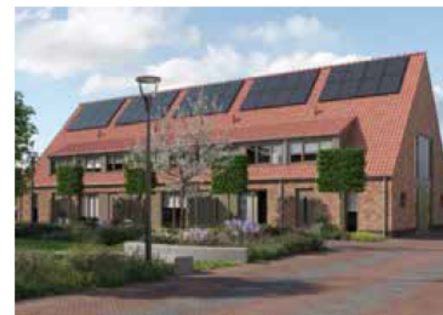
Kleinschaligheid lage goot bakstenen architectuur met pannendak
