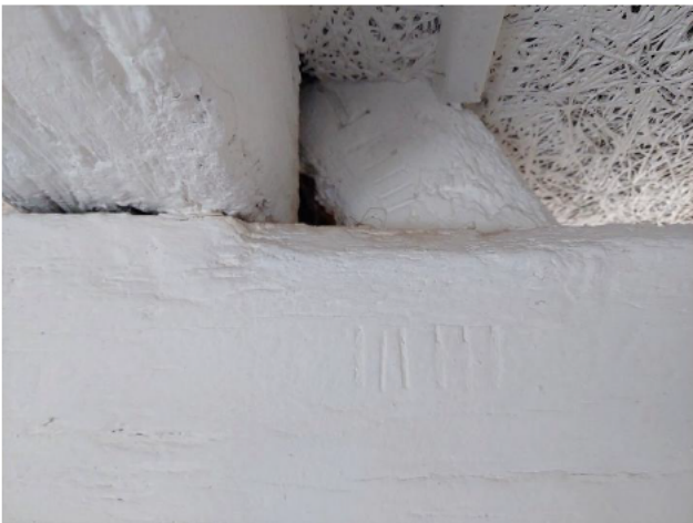
Detail met telmerk IIIIII op de dekbalk en een schoor. Rechts aansluiting van een schoor op de dekbalk en in de bint een inkeping die wijst op hergebruik.
