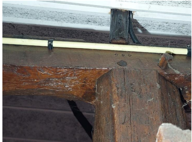
Detail met gegutste merken (00), op de linkerfoto op gebintstijl en windverband. Rechts op gebintstijl en gebintplaat.
