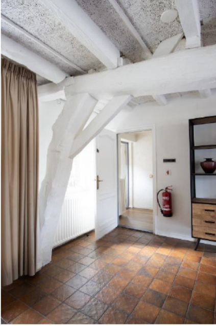
Deel van het gebint met zware gebintstijl en relatief rank korbeel. Het aanlengen van de dekbalk van het gebint ten behoeve van een nieuwe, hoger opgetrokken achtergevel. Telmerk II op de oplanger.
