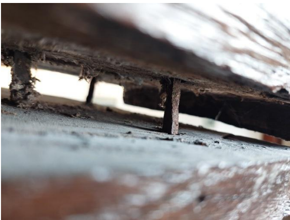
De lassen van gebintplaten zijn met wiggén én met smeedijzeren nagels vastgezet. Met het oplichten van de kap zijn oude gebintplaten hergebruikt.
