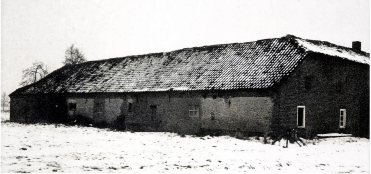
Exterieurfoto uit 1976 (Gemeentearchief). De gevel is een lappendelen van verschillende fasen muurwerk.
