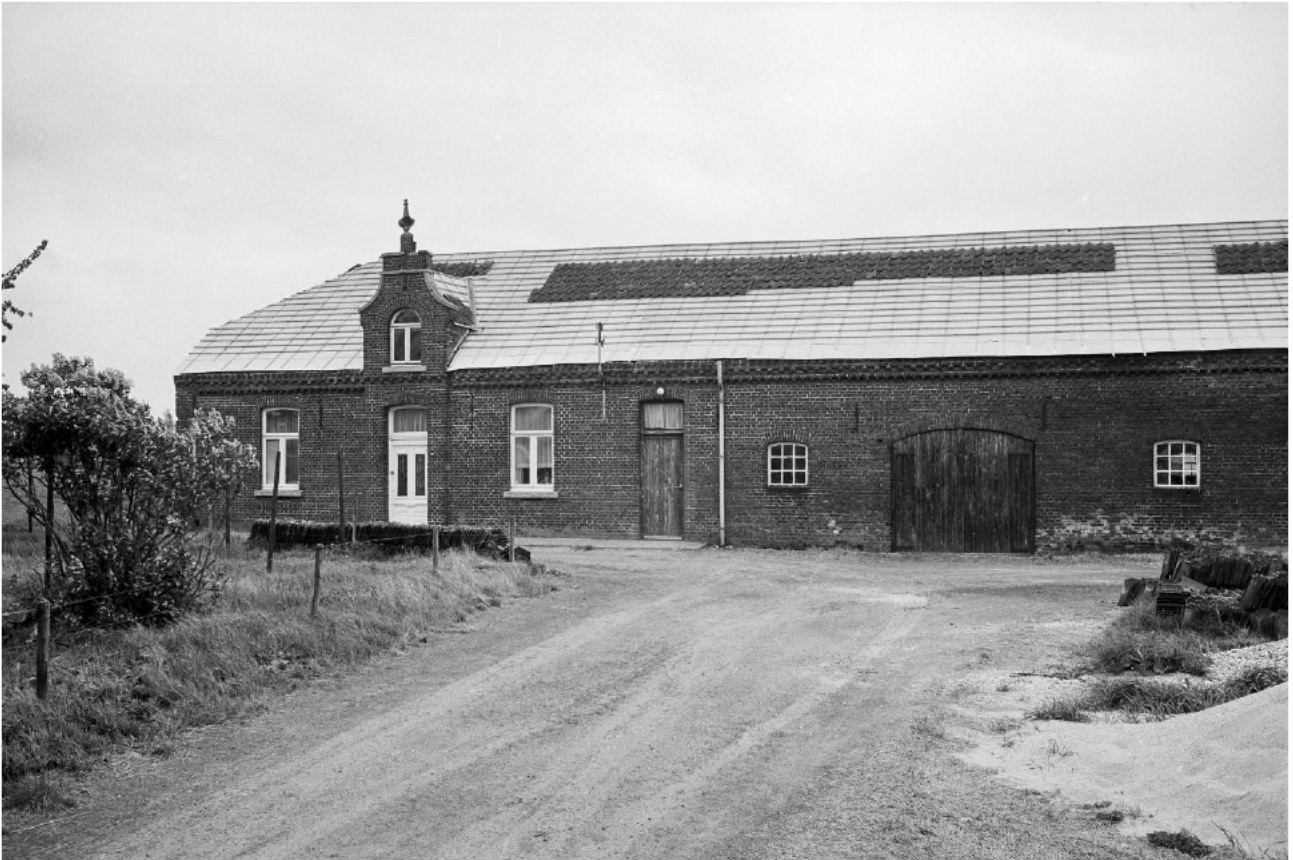
Opname in het archief van de Rijksdienst. Pannen zijn van het dak gehaald, er gaat grootschalig verbouwd worden (RCE – 175744).
