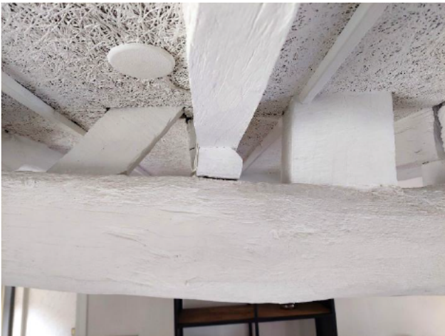
Detail van de aansluiting van de nokbalkstijl en een stijlschoor op de dekbalk van het gebint. Rechts is een afgezaagde nokbalkstijlschoor te zien. Binten liggen op klossen en zijn vrijwel zeker gebruikt toen behoefte aan een vlakke zoldervloer bestond.
