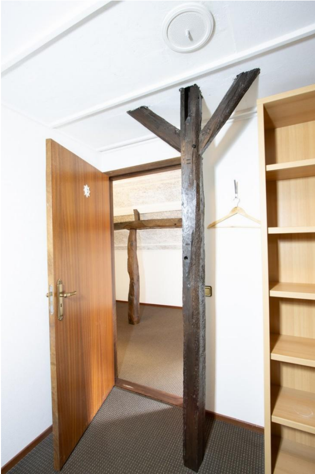
De nokbalkstijl tussen de laat negentiende-eeuwse kapspanten en moerbalken op een kinderbint opgesteld.
