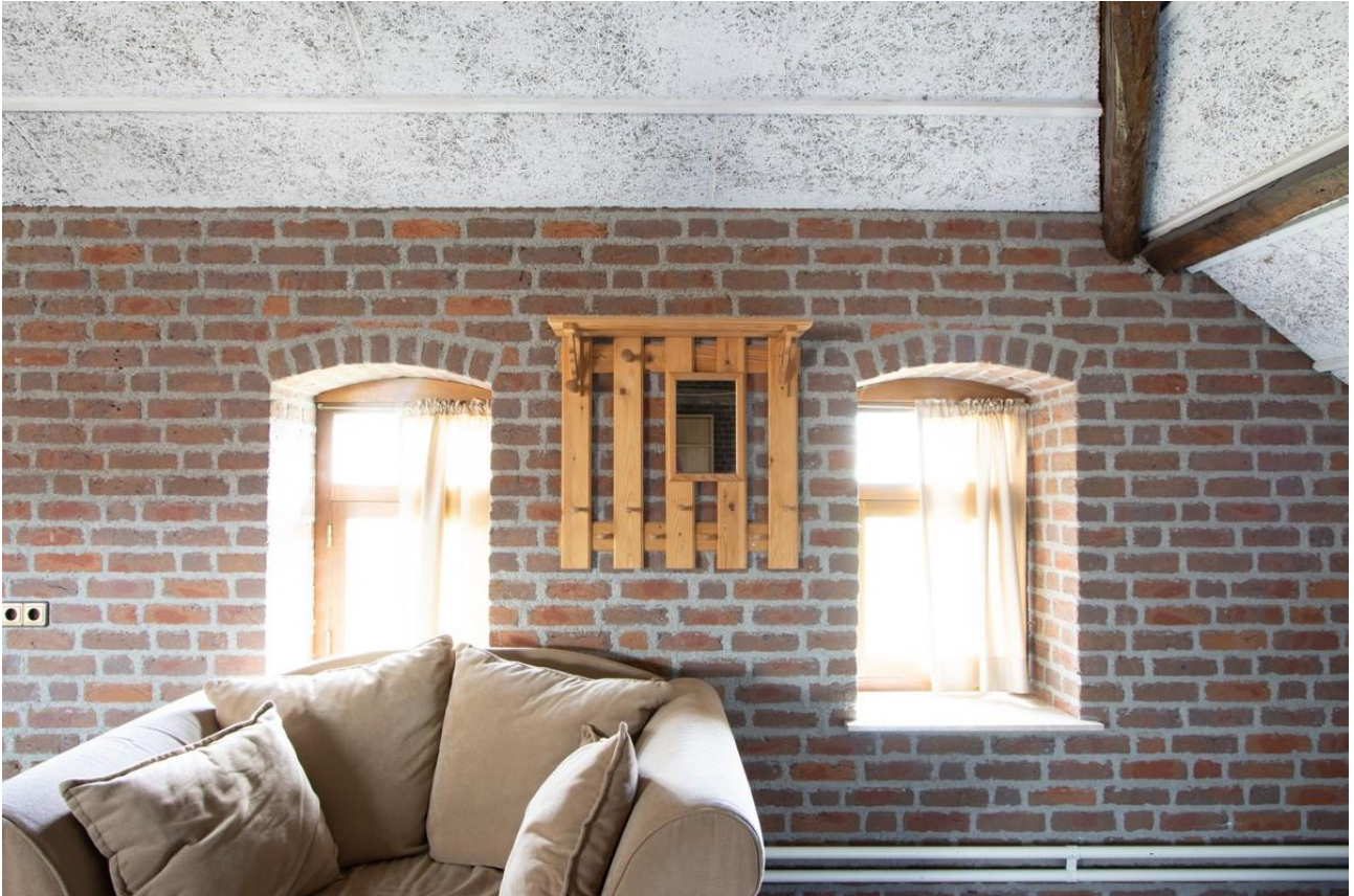
Dikke gevels als gevolg van het optrekken van binnenspouwbladen.
