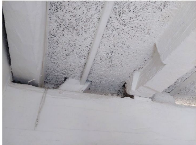
Detail met telmerk IIIIII op de dekbalk en een schoor. Rechts aansluiting van een schoor op de dekbalk en in de bint een inkeping die wijst op hergebruik.
