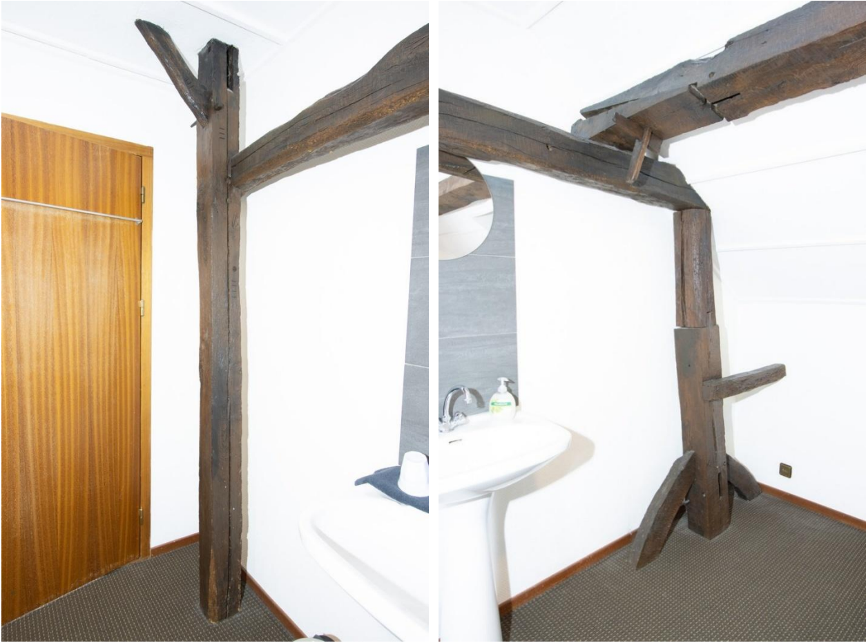
Een tweede nokbalkstijl is gesteld op een kinderbint tussen de laat negentiende-eeuwse moerbalken. De stijl is hier hergebruikt of de bint is in de plaats gekomen van een ouder gebint dat werd gesloopt. Op dat laatste wijst onder andere het bestaan van één van de wurmtstijlen in lijn met de nokbalkstijl.
