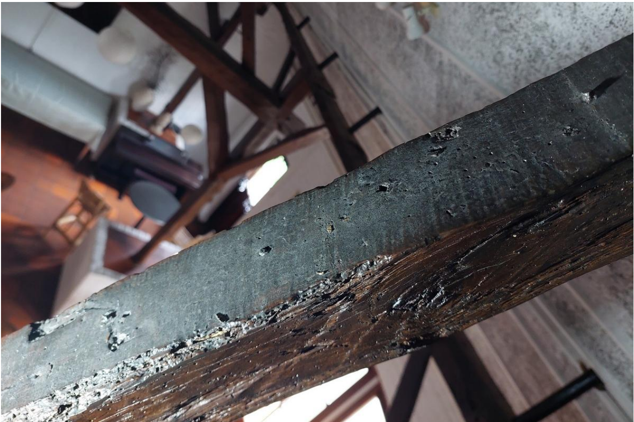
Spijergatreeksen tonen aan dat het hout van (een deel van) de nokstijlschoren is hergebruikt.
