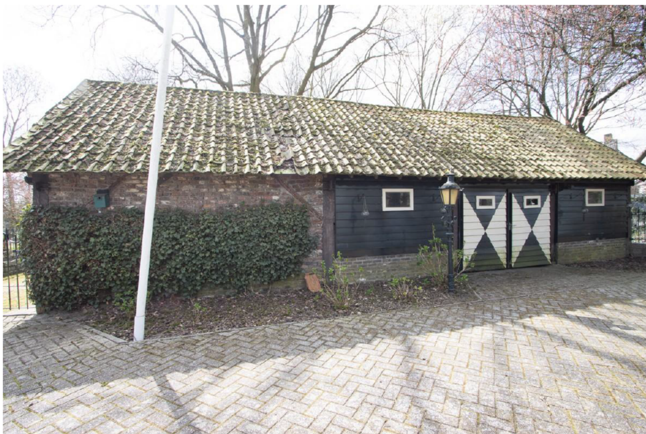
Eén van de gevels waarin onder andere van sloop afkomstige baksteen is hergebruikt.
