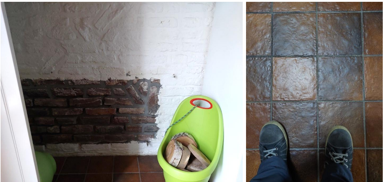
In een kast is een deel van de muren niet overschilderd en is twintigste-eeuws (XX-B) metselwerk in portlandcement te zien. Rechts vloertegels uit de jaren zeventig van de vorige eeuw.
