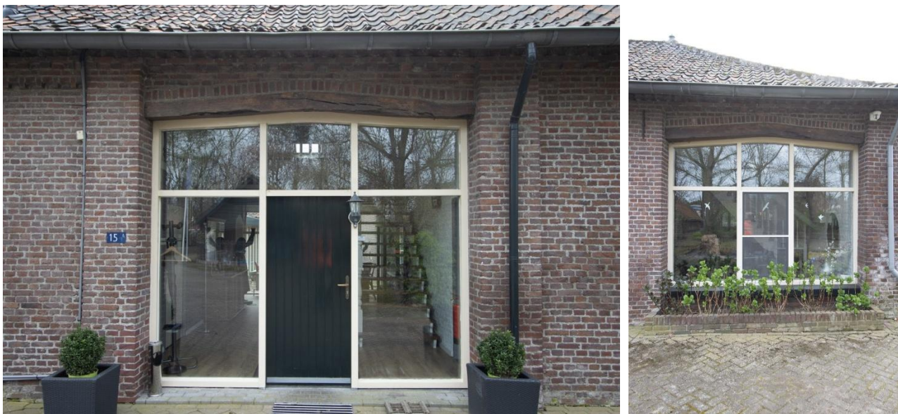
Links de voormalige doorrit naar de binnenplaats. Rechts de voormalige inrit van de schuur/stal die in dienstjaar 1897 werd gebouwd.
