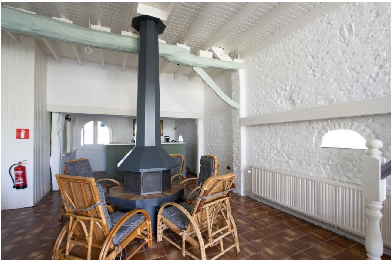
De constructie van de zoldervloer.
