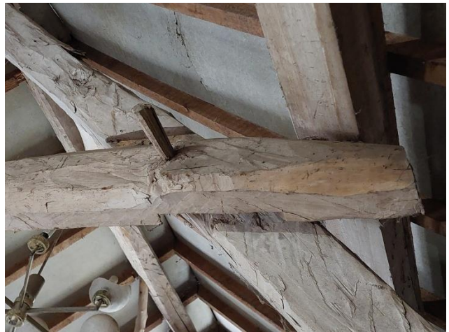
Detail van de met draadnagels (links) en toonagels (rechts) vermaakte houtverbindingen.
