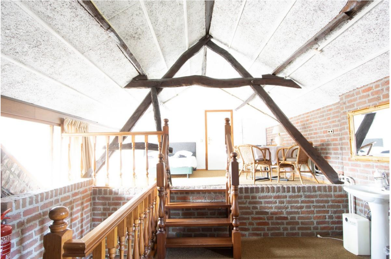
De zolder waarin metselwerk en afwerkingen uit de jaren tachtig stammen.
