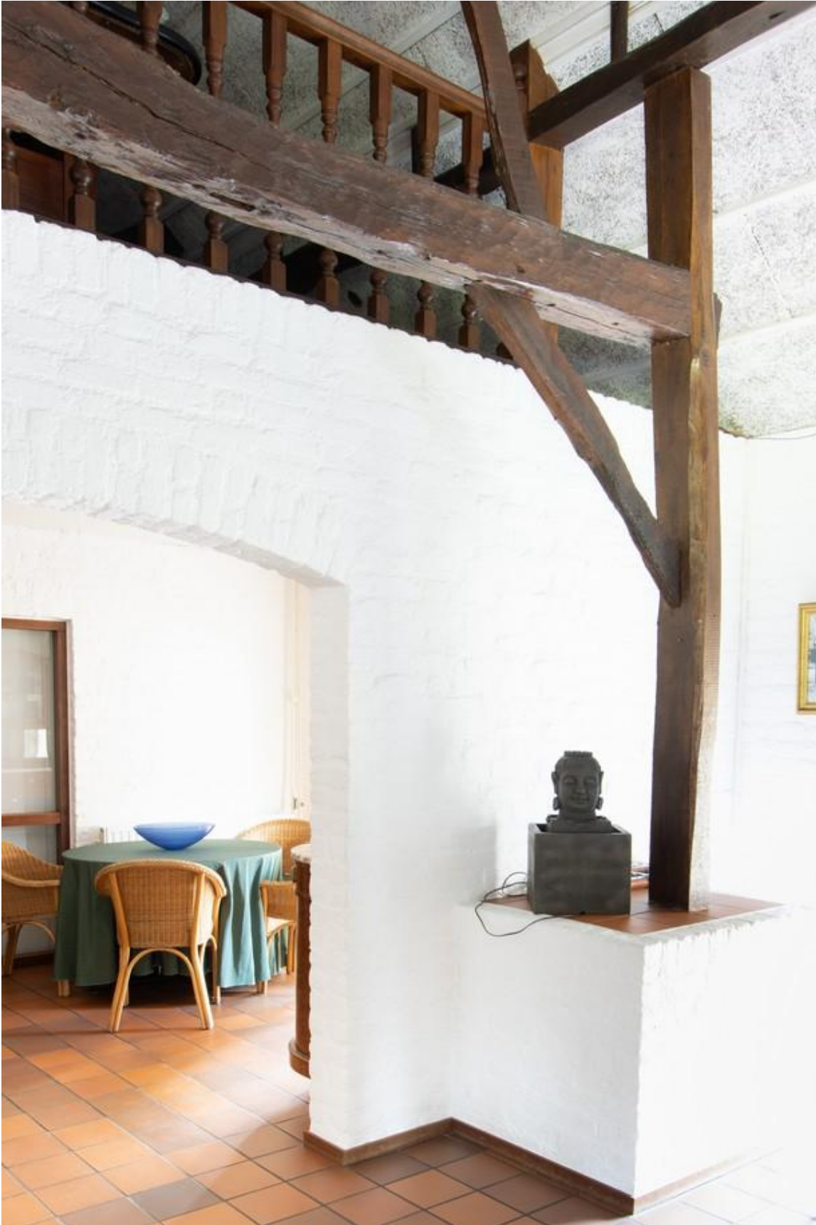
Deel van het 'vierde' gebint dat duidelijk afwijkt van de overige en mogelijk in 1877-1878 nieuw is geconstrueerd met hergebruik van een oudere ankerbalk. Aan de onderzijde van die ankerbalk onder andere een pengat voor een verdwenen stijl en gaten waar in het verleden vlechtstaken hebben gezeten.
