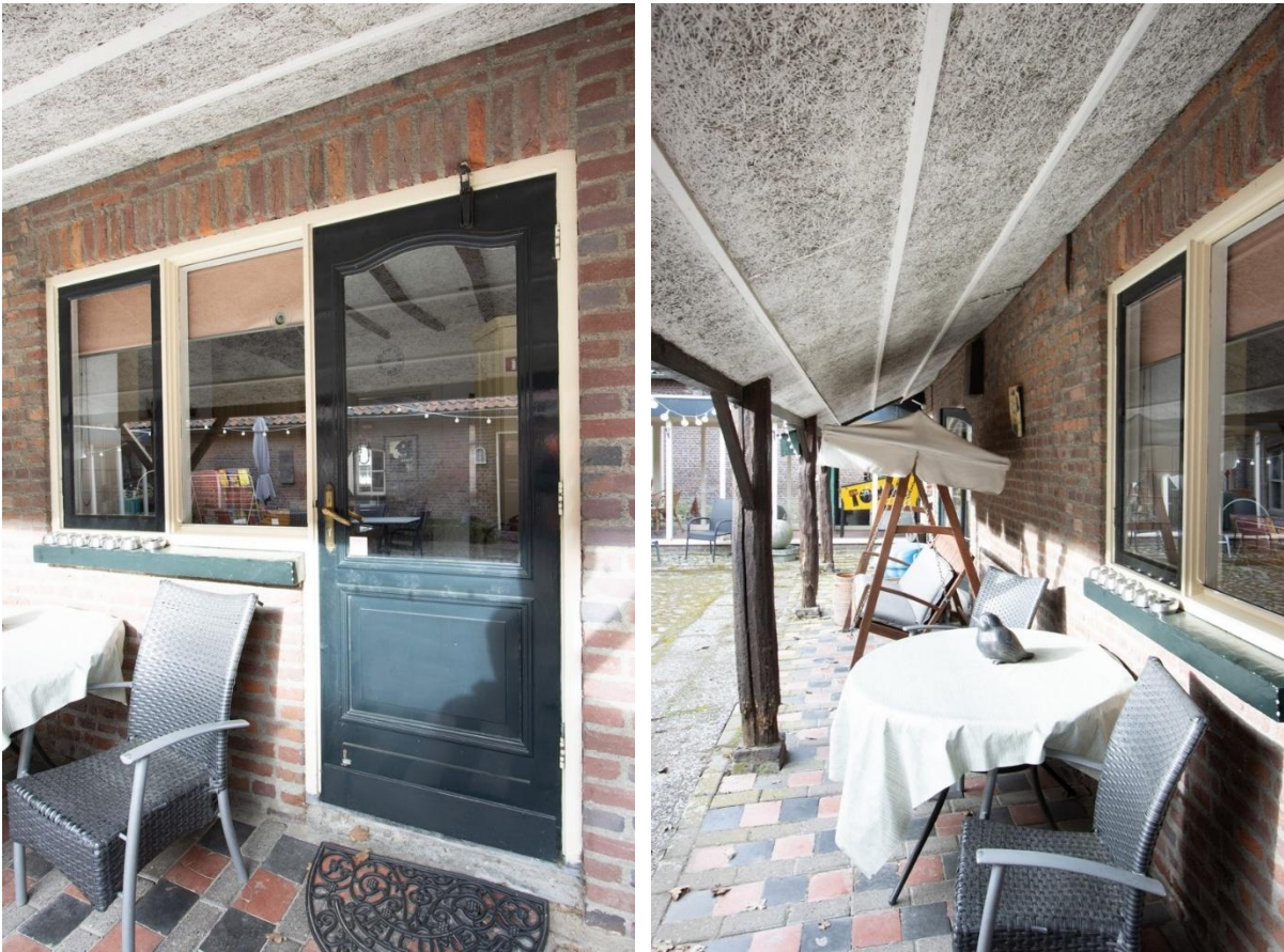
Metselwerk in halfsteens verband en recente(re) gevelelementen.
