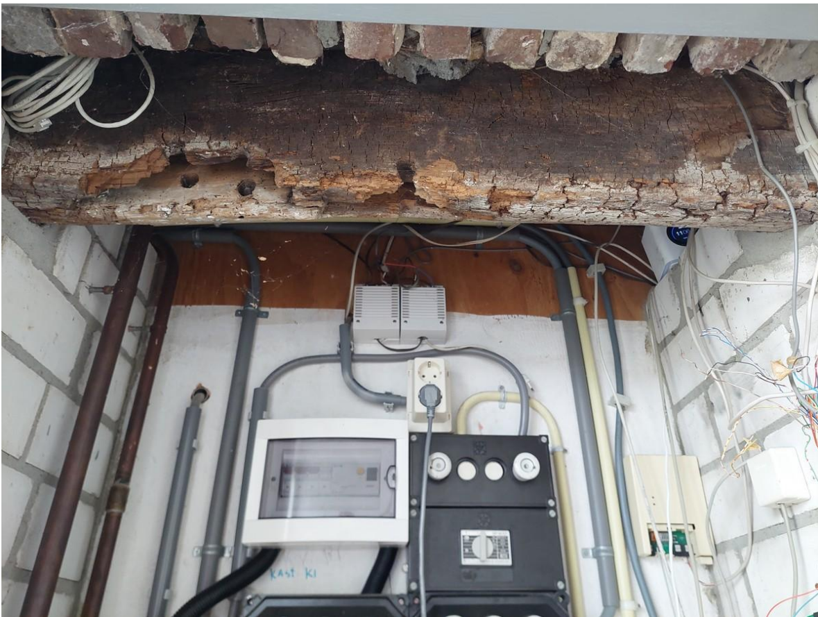
Deel van de balk waarop bovenstaand spant is gesteld.
