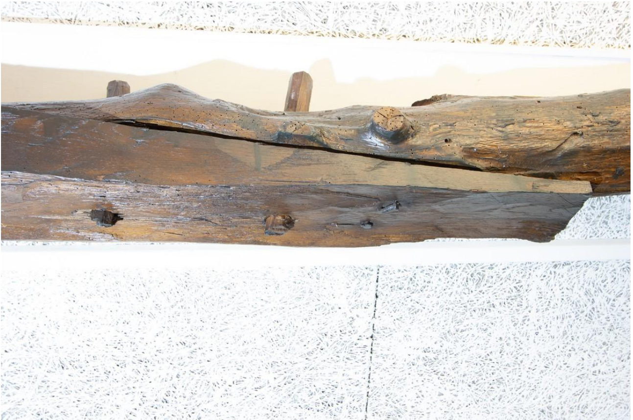
Gordingen zijn met lussen, spijkers en toognagels onderling verbonden.
