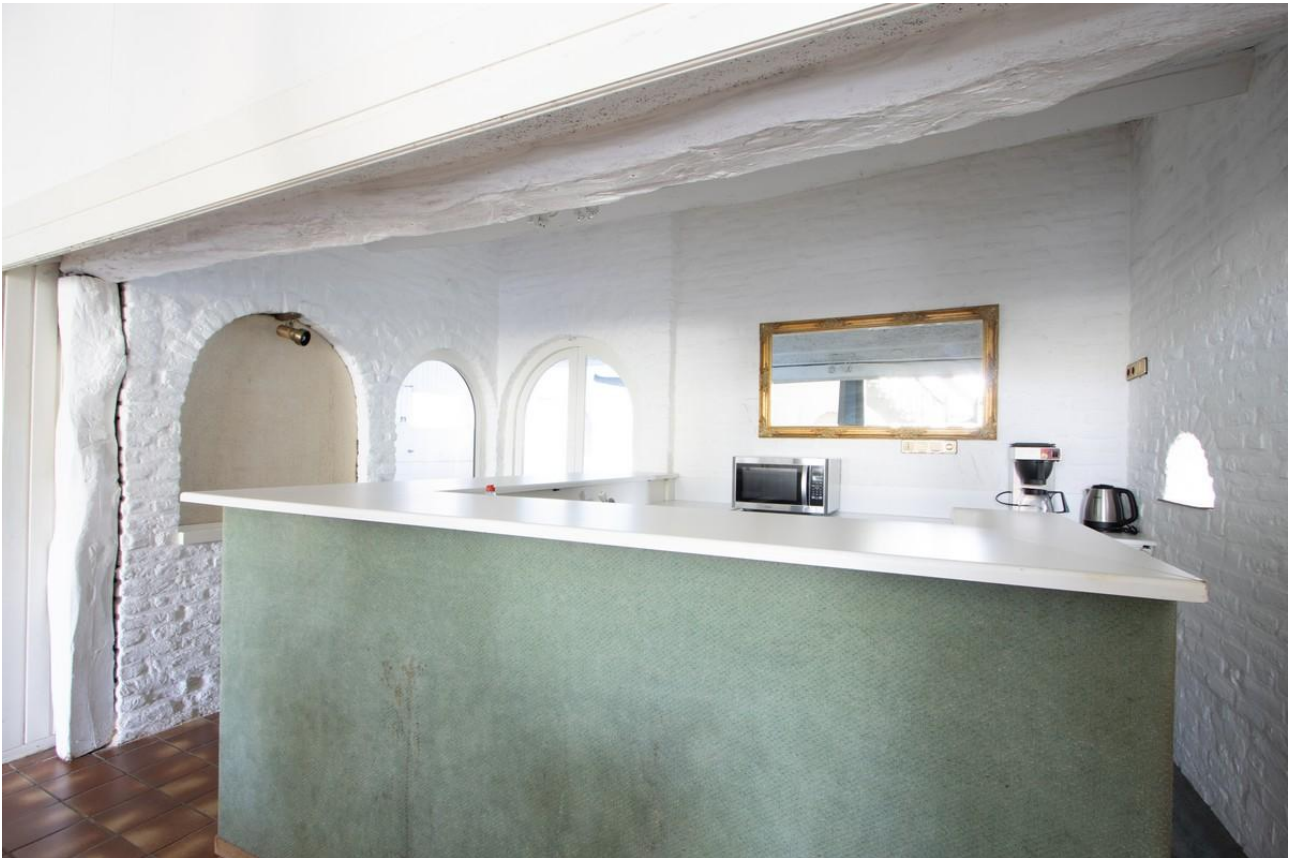
De bar, muurwerk later gewit.
