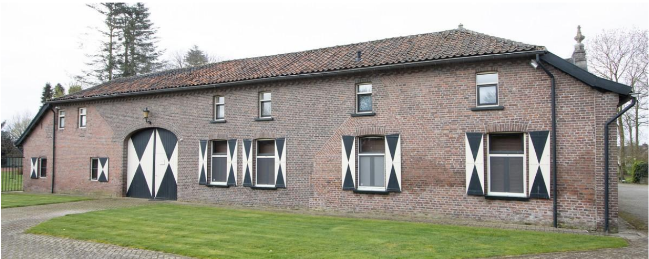
De linker zijgevel, historisch de meest interessante van alle gevels.
