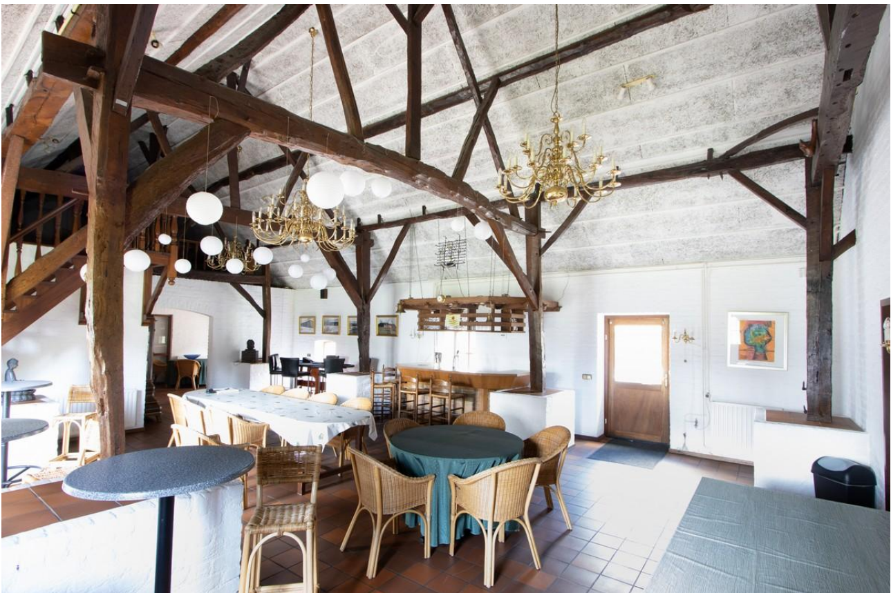
De gebintconstructie, met rechts in beeld hoger aangezette windverbanden wat op de plaats van een vroegere deel in die travee wijst.
