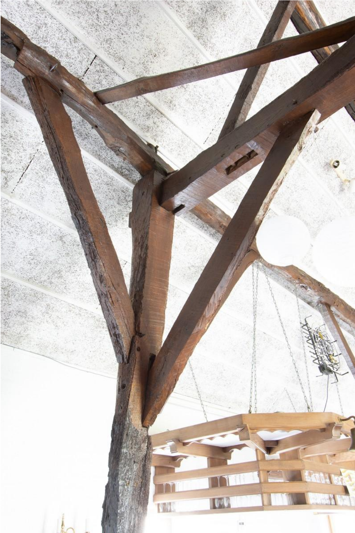
Op deze foto zien we onder andere de handzaagsporen op de gebintstijl, maar ook de uit oudere context afkomstige ankerbalk met aan de onderzijde in onbruik geraakte pengaten.
