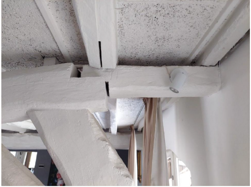
Deel van het gebint met zware gebintstijl en relatief rank korbeel. Het aanlengen van de dekbalk van het gebint ten behoeve van een nieuwe, hoger opgetrokken achtergevel. Telmerk II op de oplanger.
