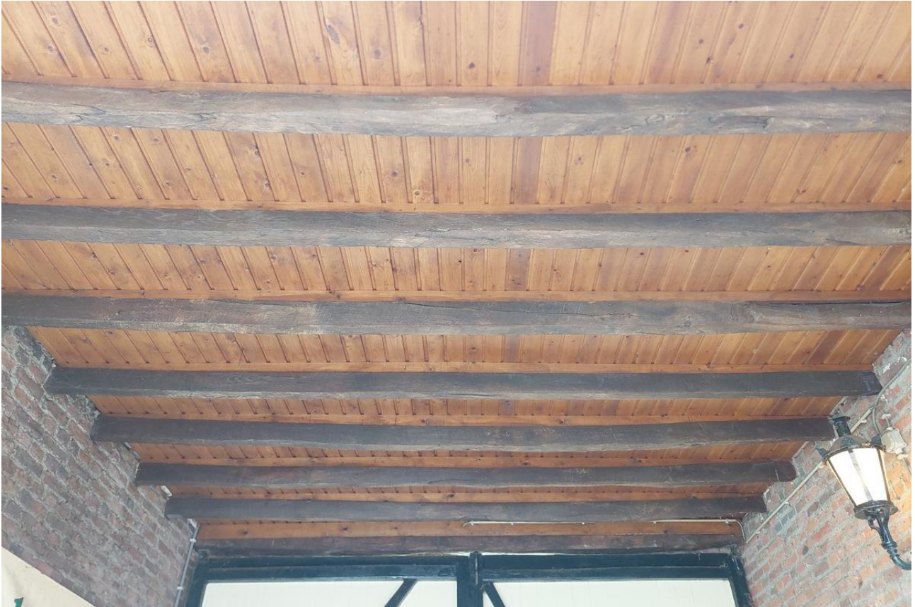
De zolderbalklaag boven de doorrit, vrijwel zeker uit 1895.
