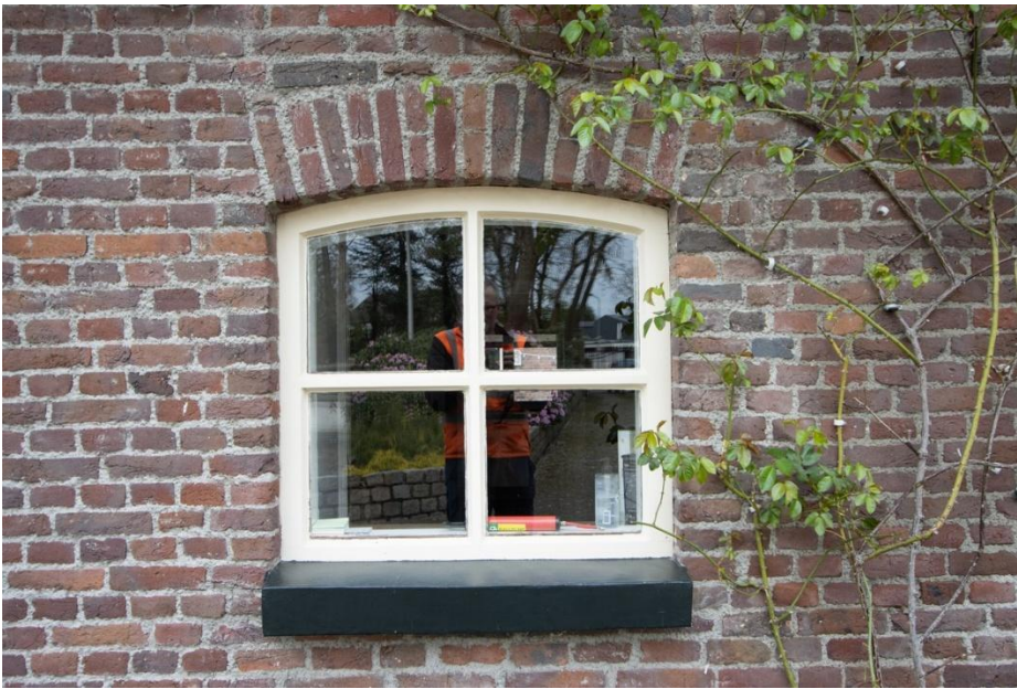
Het omvormen van een deuropening naar een vensteropening is opvallend netjes gedaan. Daarbij helpt dat de gevel een keer opnieuw is gevoegd.
