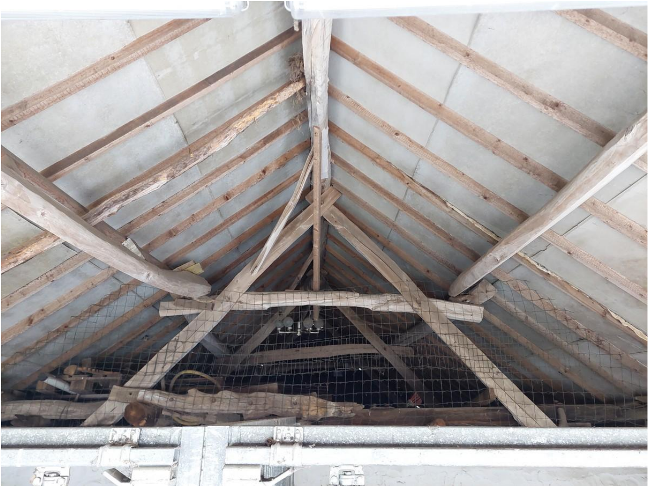
Deel van de constructie, vervaardigd uit lokaal hout. Er zijn toonagels en draadnagels toegepast. Op de daksporen liggen cementplaten.
