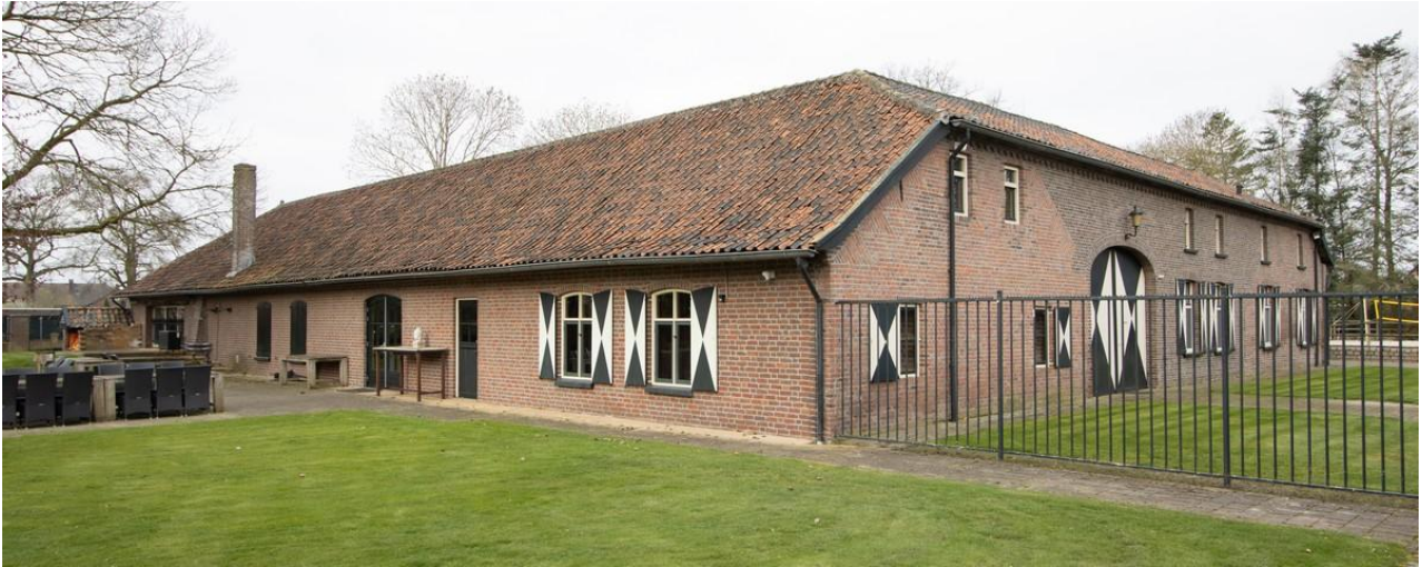
De achtergevel is volledig uit de tijd van de beautyfarm.
