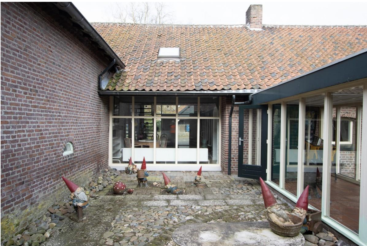
In het verleden kon de boer tussen boerderij en schuur/stal met kar de binnenplaats bereiken. Dit is ondanks de plaatsing van puien en de inrichting van een hal nog wel herkenbaar.
