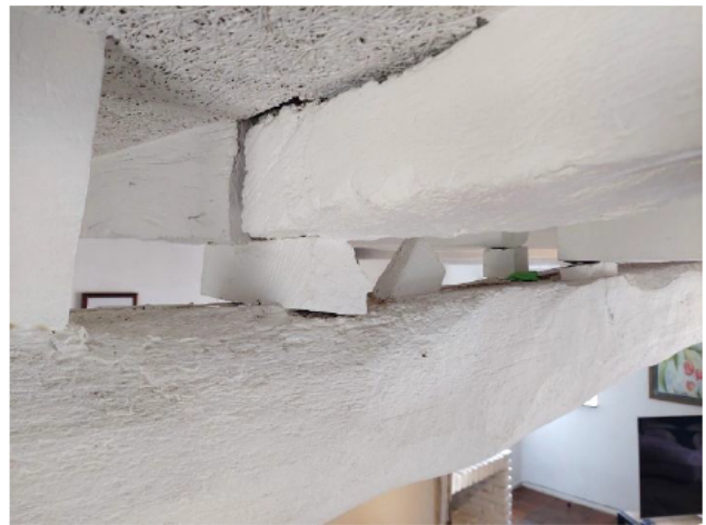
Detail van de aansluiting van de nokbalkstijl en een stijlschoor op de dekbalk van het gebint. Rechts is een afgezaagde nokbalkstijlschoor te zien. Binten liggen op klossen en zijn vrijwel zeker gebruikt toen behoefte aan een vlakke zoldervloer bestond.
