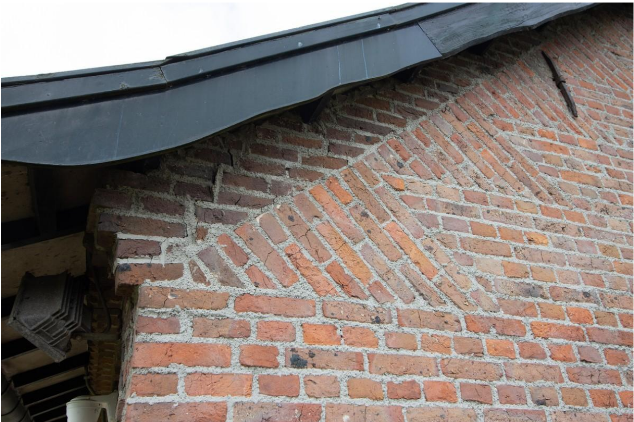
Het dak is opgelicht met het maken van een nieuwe achterevel. De gevel is gereinigd en opnieuw gevoegd.
