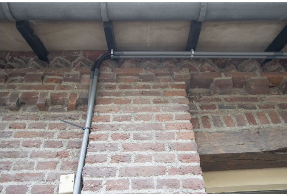
Faseverschil komt tot uitdrukking in verschil van detaillering van de kroonlijst.
