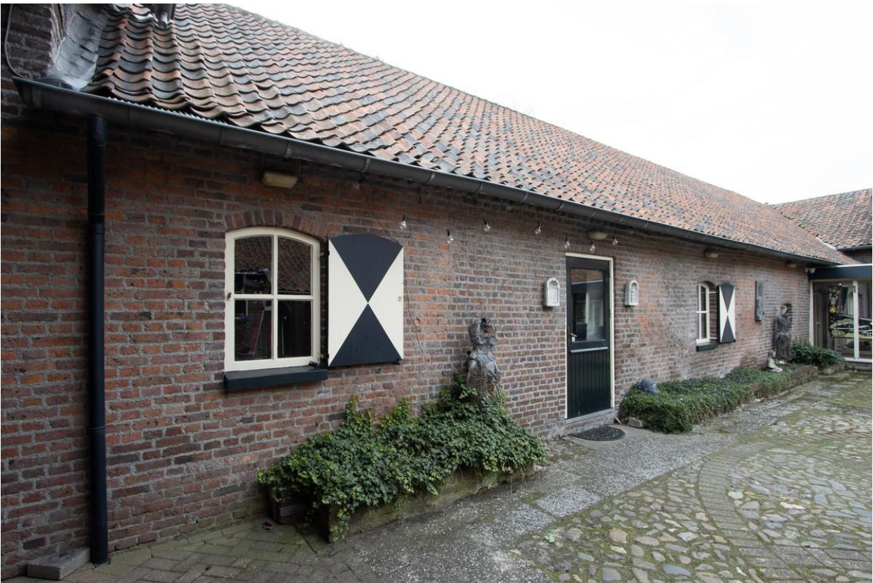
De gevel in de huidige toestand.
