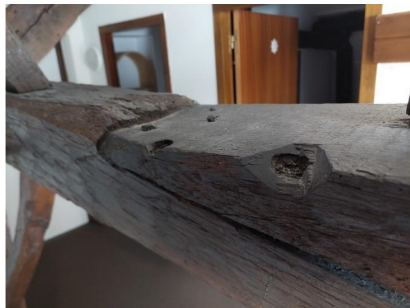
De lassen van gebintplaten zijn met wiggén én met smeedijzeren nagels vastgezet. Met het oplichten van de kap zijn oude gebintplaten hergebruikt.
