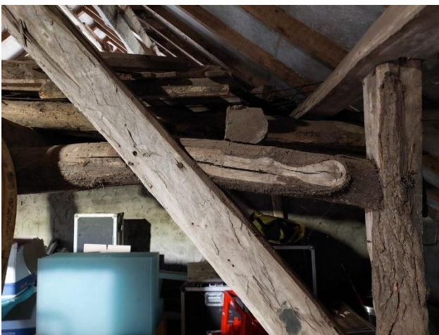
Detail van de met draadnagels (links) en toonagels (rechts) vermaakte houtverbindingen.
