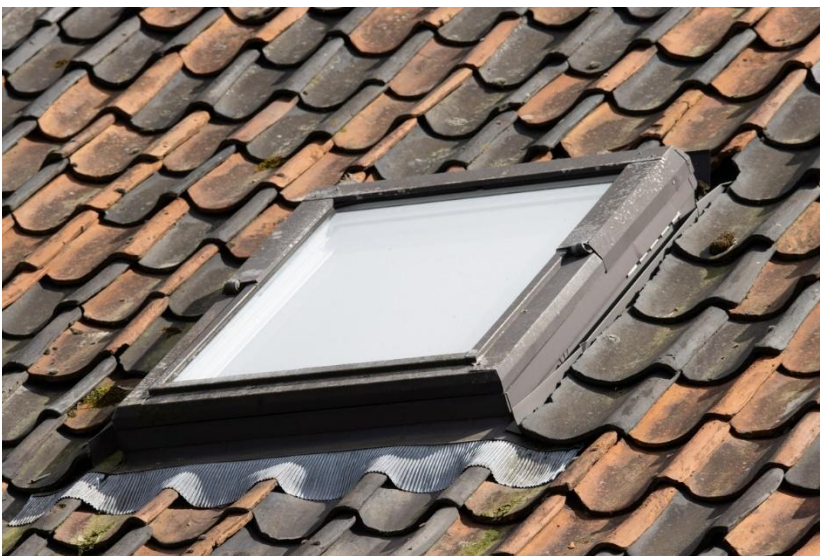
Eén van de dakramen.
