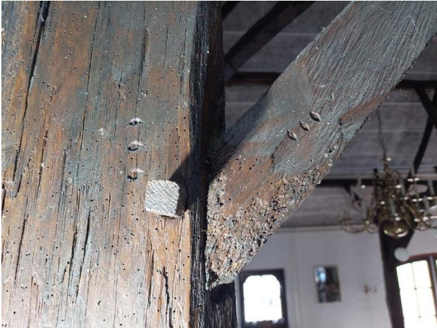
Detail met gegutste merken (00), op de linkerfoto op gebintstijl en windverband. Rechts op gebintstijl en gebintplaat.
