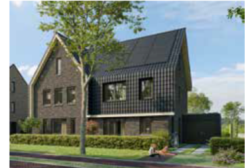
Aandacht voor kleinschaligheid met dak
