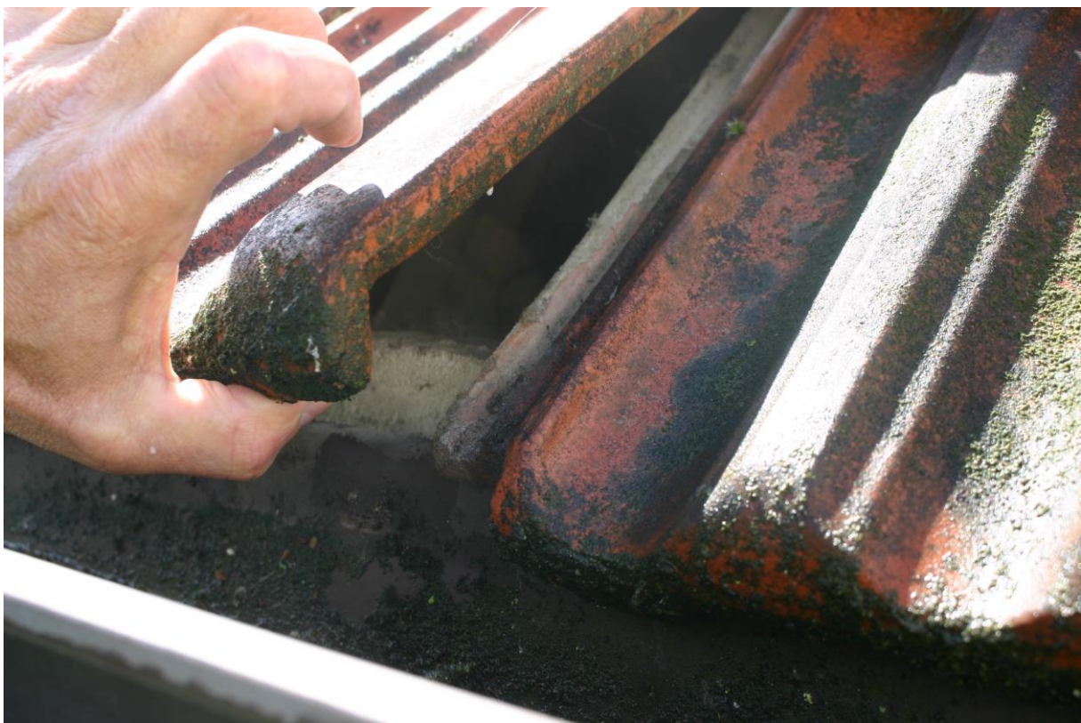
Figuur 4.2.3. Vogels hebben onder de onderste rij dakpannen te weinig ruimte om naar binnen te gaan.
