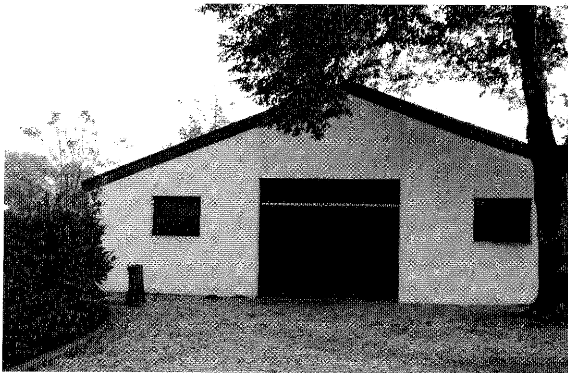
Foto bestaande linkerzijgevel. (bestaande gevel is gestukadoord en wit geschilderd)
