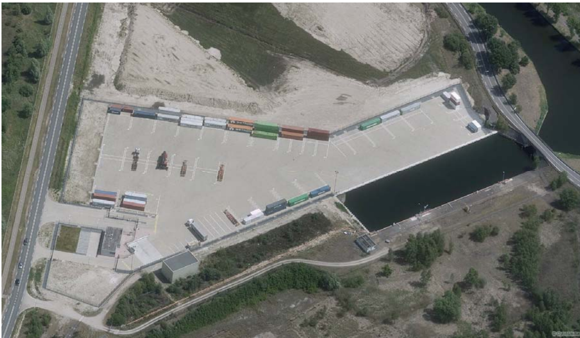
Figuur 6: Luchtfoto oblique (5 mei 2018) van insteekhaven, bedrijfsterrein en omgeving aan westzijde.
