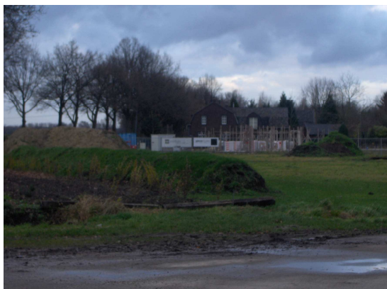
Foto 24: aanleg wal met beplanting aan het Pylsstraatje op het nog onbebouwde perceel grenzend aan perceel aanvrager
