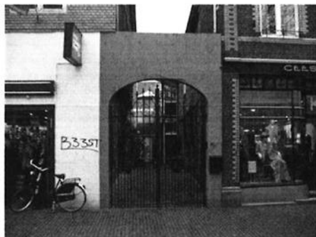
Steeg tussen Langstraat 4 en 6 (vakwerkgevel)
