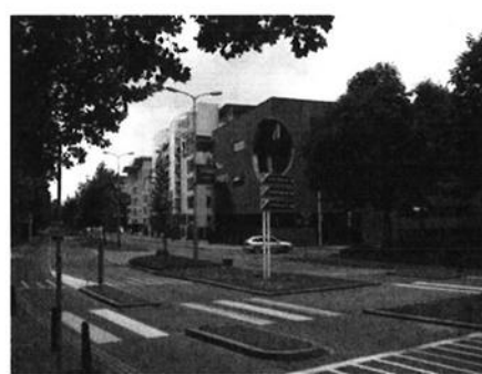
Nieuwbouw aan Kasteelsingel
