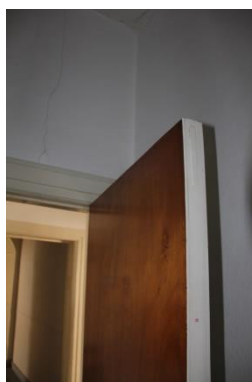
Afb. 83 Authentieke deur van de middenkamer, afgetimmerd met vlakke plaat.
