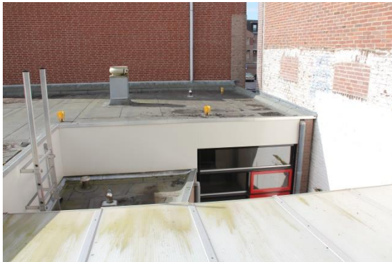
Afb. 128 Aanbouwen, gezien vanuit de eerste verdieping van het hoofdvolume.
