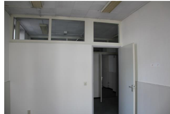
Afb. 61 Systeemwand, gezien vanuit de noordoostelijke kamer.
