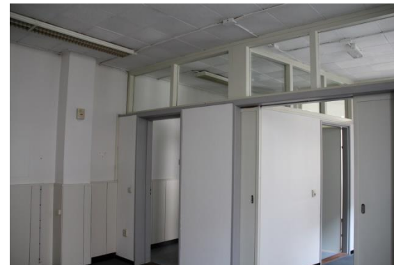
Afb. 63 Systeemwanden scheiden de kamers. De muuraanzet (links) geeft de locatie van een voormalige muur weer.
