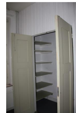
Afb. 85 kastenwand met kraalschroten met kast en zoldertrap.
