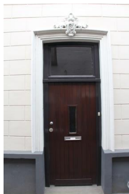
Afb. 18 De deur, links in de gevel is niet authentiek. Hier zat voorheen een raam.
