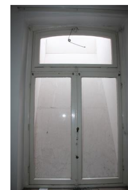
Afb. 87 Authentiek venster in middenkamer (bovenlicht is een vervanging).
