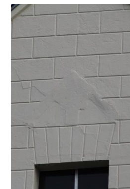
Afb. 22 Detail boven het voormalig hijsluik.
