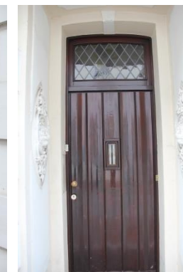
Afb. 12 Voordeur met bovenlicht, 1960.
