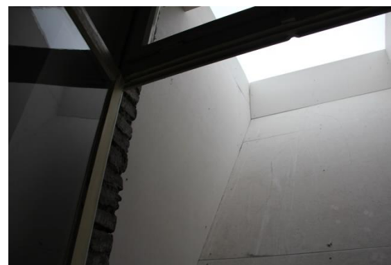
Afb. 86 Koof van gipsplaten van raam in middenkamer.
