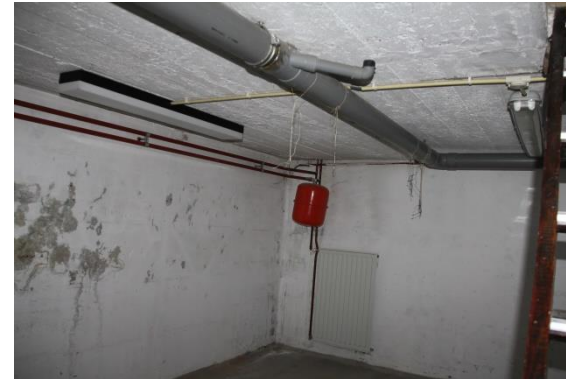
Afb. 121 De tweelaags aanbouw onder plat uit 1933.
