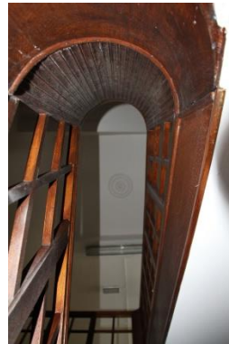
Afb. 46 Detail van trap en rozet op plafond.
