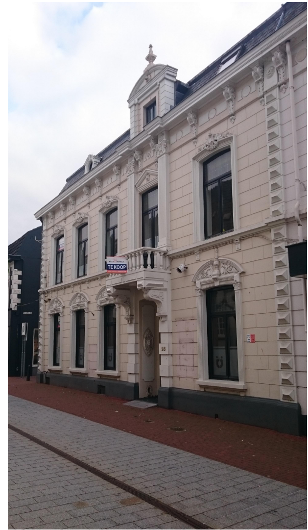
Voorgevel bestand Zijde Maasstraat
