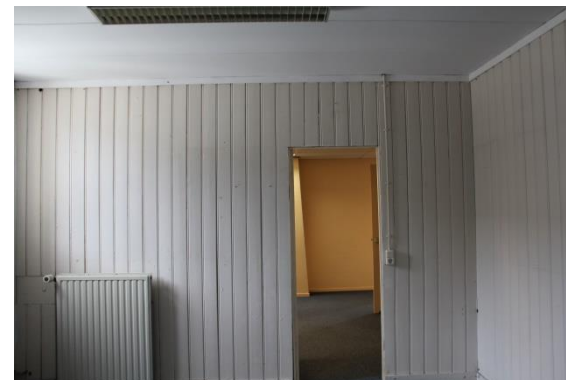
Afb. 110 Wand van kraalschroten aan de noordzijde van de zolder: 1960.
