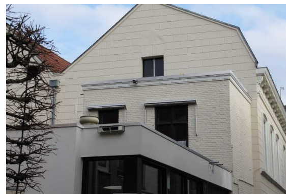
Afb. 21 Achtergevel van de rechter topgevel.
