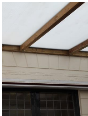
Afb. 26 Een van de twee hanenkammen boven het liggend venster.
