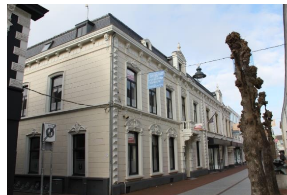
Afb. 3 Aanzicht vanuit het noordoosten
