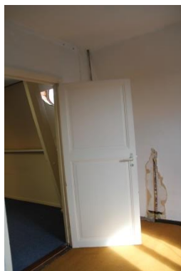
Afb. 107 De drie meidenkamers hebben nog de oorspronkelijke paneeldeuren.
