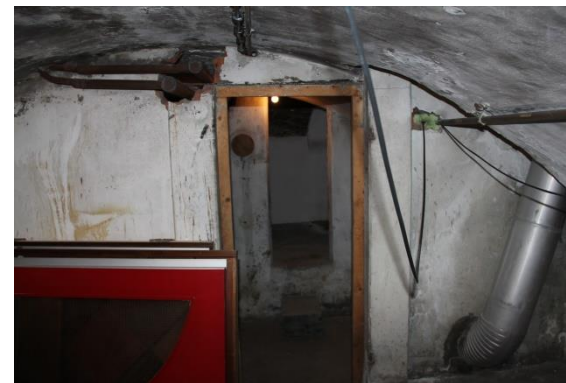
Afb. 31 Oostelijke kelder, gezien richting Maasstraat.
