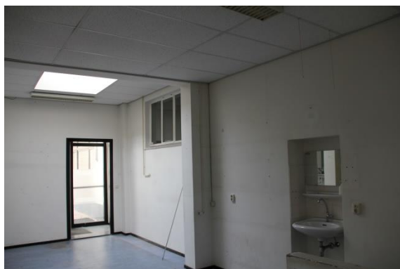
Afb. 27 Voormalige buitengevel met linksboven een relict van een voormalig venster.
