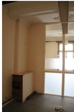
Afb. 51 Authentieke boezem met kroonlijst en bakstenen mantel (weggetimmerd).
