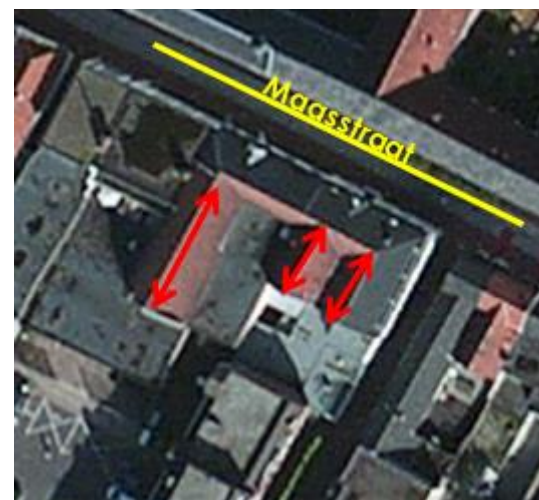
Afb.144 Luchtfoto met daarop de dakstructuur van het complex Maasstraat 26-28 (vergelijk met de kadastrale minuutkaart, afbeelding 131).
