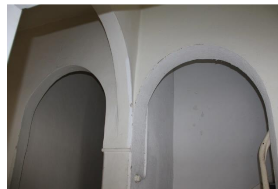
Afb. 98 Drie togen in de oostelijke gang (bij de rechter toog is de trapopgang naar de zolder).
