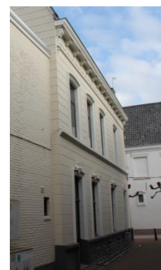
Afb. 15 Oostelijke zijgevel (Kromstraat)
