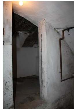
Afb. 34 Blik in voormalige kolenkelder (oostelijke kelder).
