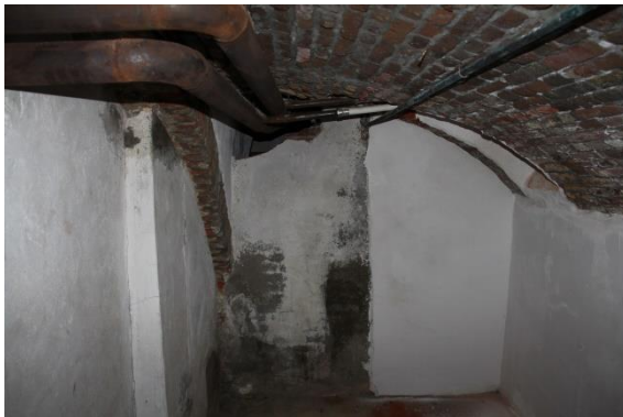
Afb. 35 Haaks op de kelder geplaatst tongewelf.
