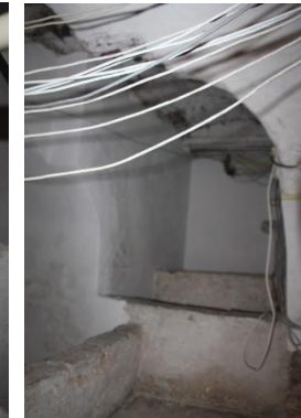
Afb. 38 'Gang' in westelijke kelder, waarschijnlijk ontsluiting met oorspronkelijke steeg.
