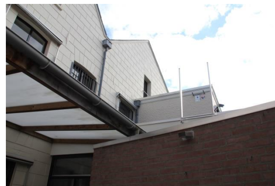
Afb. 126 Door de diverse volumes en de overkapping is een onrustig geheel ontstaan aan de achterzijde van het pand.
