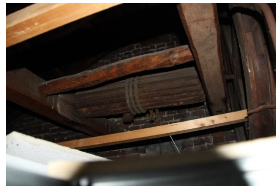
Afb. 116 Kapconstructie van de vleugel aan de Van Berlostraat.
