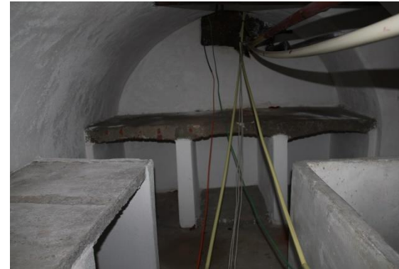
Afb. 37 Westelijke kelder, noordelijke ruimte.
