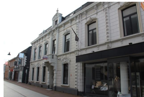
Afb. 4 Aanzien vanuit het noordwesten: het buurpand is in opzet en detaillering identiek.
