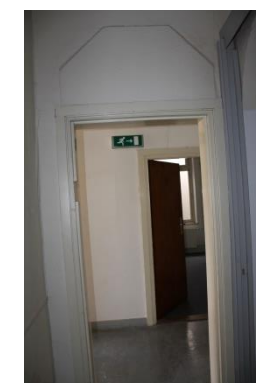
Afb. 99 Twee togen in de gang tussen de twee noord-zuidgangen.
