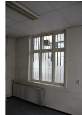
Afb. 124 Zesruits venster op de begane grond.
