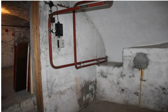
Afb. 33 Centrale ruimte in oostelijke kelder.
