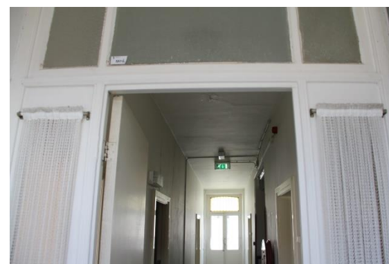
Afb. 77 Het authentieke kozijn dat in of na 1960 op de verdieping is geplaatst ten behoeve van een hier gerealiseerde badkamer.
