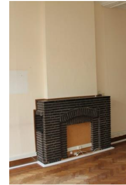
Afb. 54 Schouwmantel in zuidelijke kamer.
