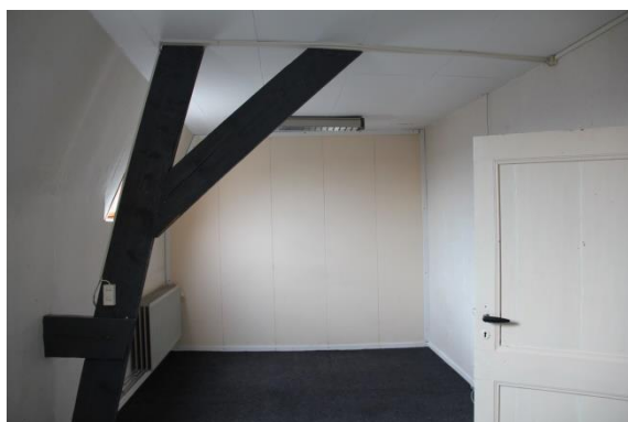
Afb. 108 Een van de spanbennen, met korbeel (bevestigd met bouten) en schoor (bevestigd met deuvels).
