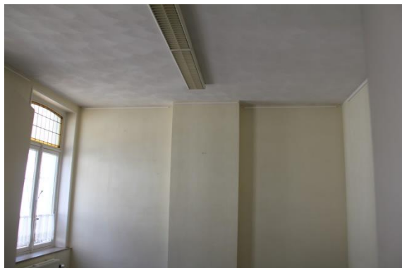
Afb. 91 Kamer ten oosten van de hoofdgang.
