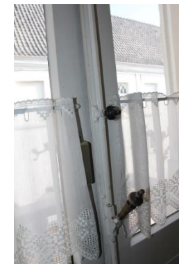
Afb. 75 Authentiek hang- en sluitwerk Franse deuren balkon.
