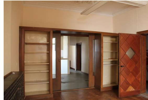
Afb. 53 En suite kast met schuifdeuren.
