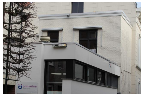
Afb. 117 De tweelaags aanbouw onder plat uit 1933.
