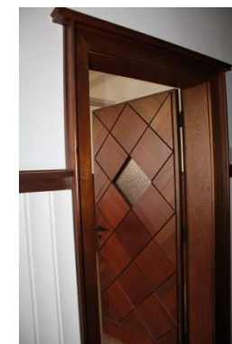
Afb. 43 Deur uit 1960. Mogelijk dat achter het kozijn nog het oorspronkelijke exemplaar zit.
