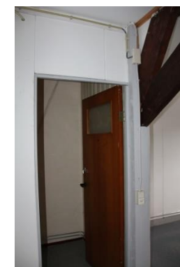
Afb. 113 Deur uit de jaren zestig, westelijke zolder.
