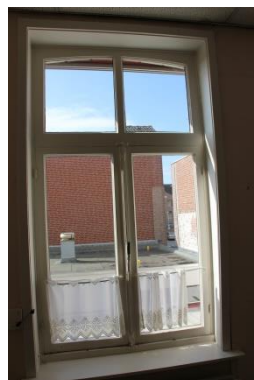
Afb. 89 Venster uit 1960 in de achtergevel.
