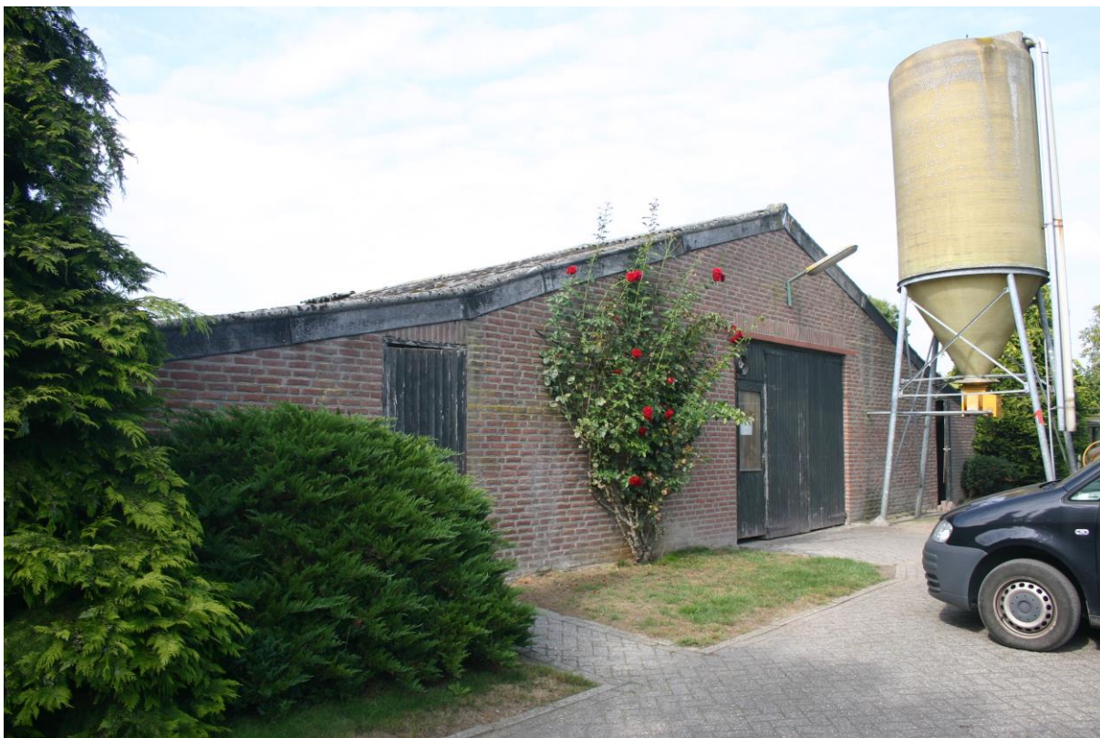
Figuur 2. De te slopen schuur
