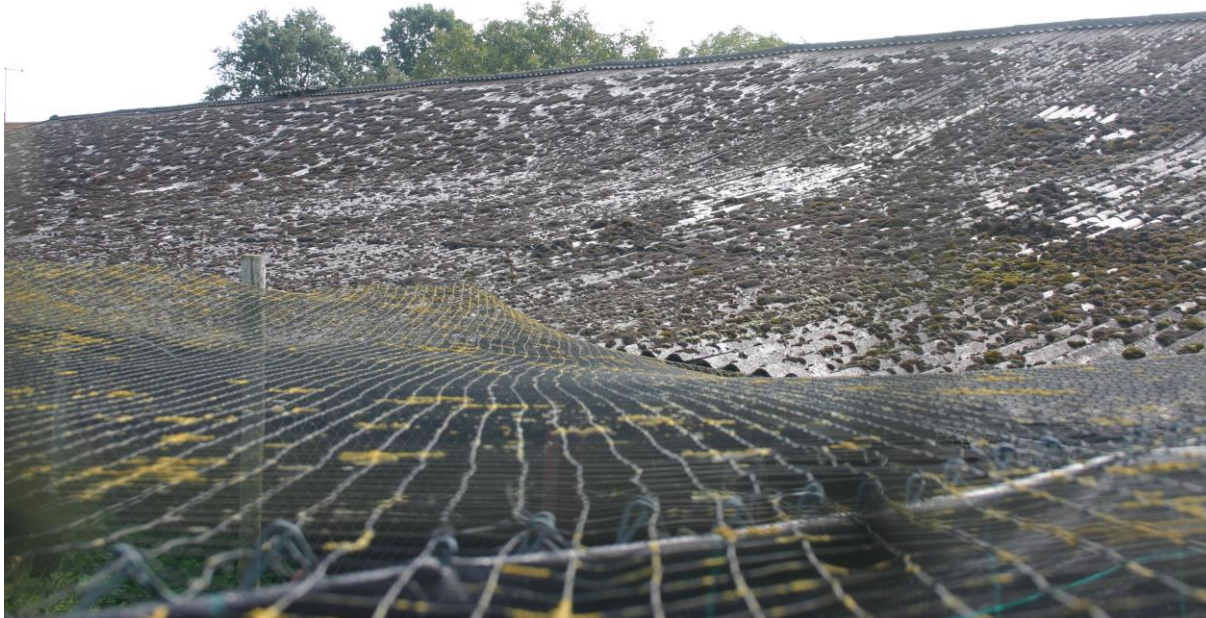
Figuur 3. De schuur vanuit het noorden gezien, met netten op de voorgrond die aansluiten op het eternieten dak.
