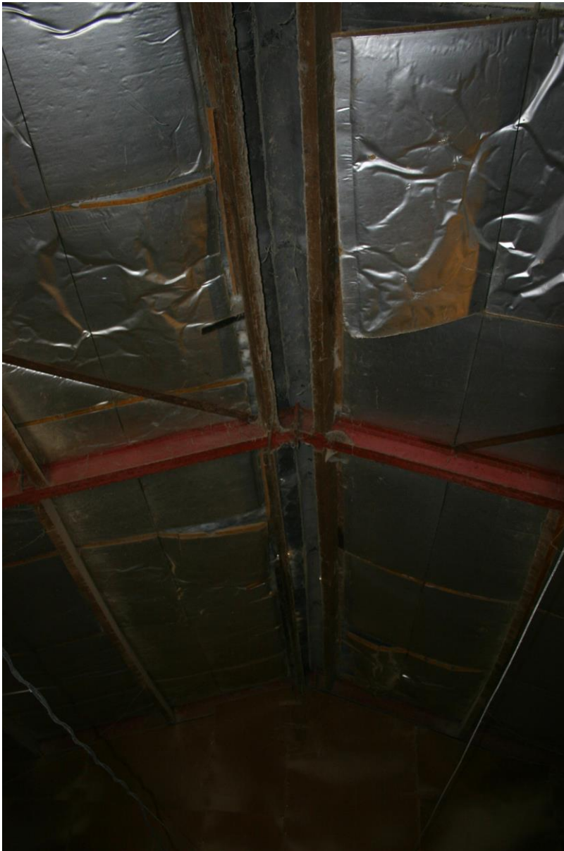
Figuur 6. De nok van het dak van onderaf gezien.
