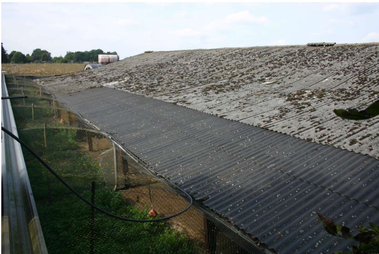
Figuur 4. Zicht op de schuur (met netten op de voorgrond) vanuit het zuiden.
