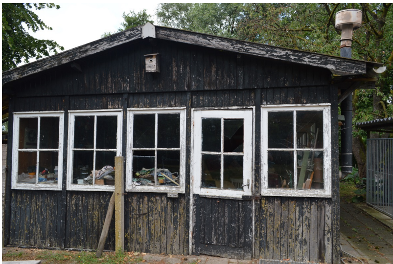
Figuur 4.2. Bestaande houten schuur.
