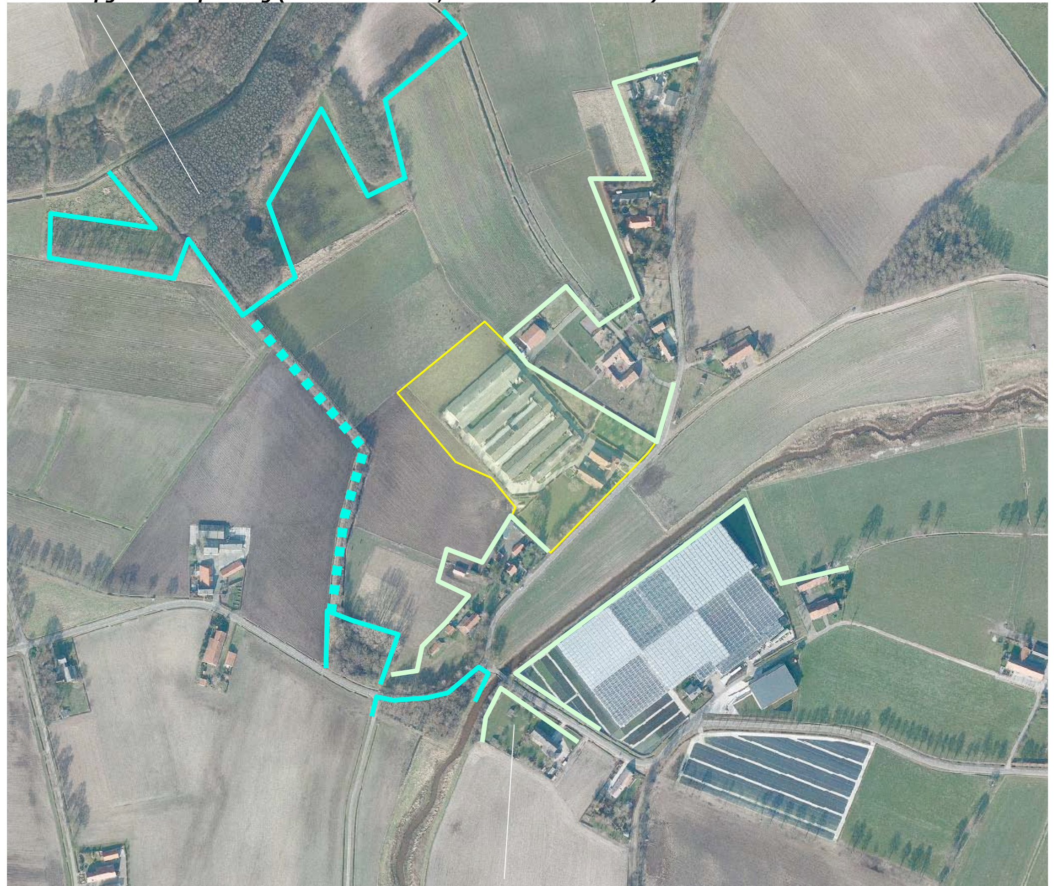
bebouwing en beplanting op omliggende buurerven
