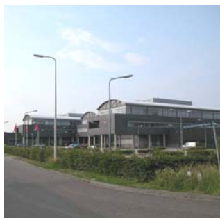
figuur: kantoor Centrum-Noord
