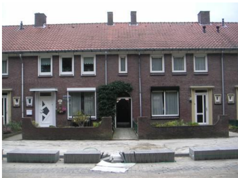
Wederopbouw aan de Mariënhagelaan
