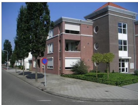
Nieuwbouw hoek Victor de Stuersstraat
