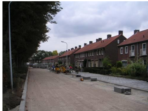
Wederopbouw aan de Mariënhagelaan
