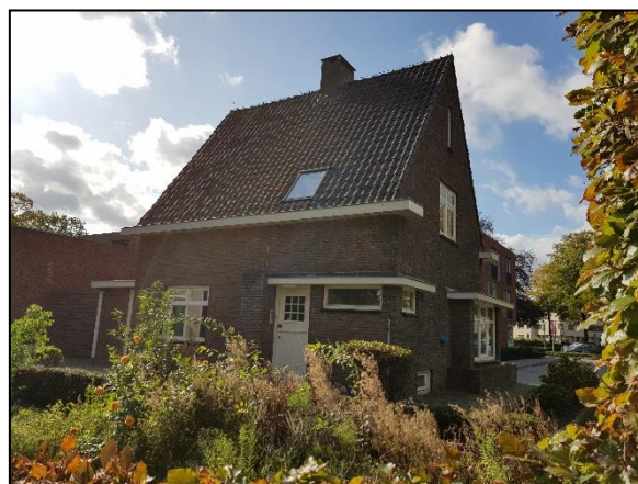
Figuur 5. Het te slopen gebouw vanaf noorden
