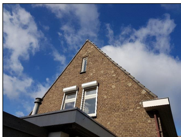
Figuur 9. Het te slopen gebouw vanaf oosten
