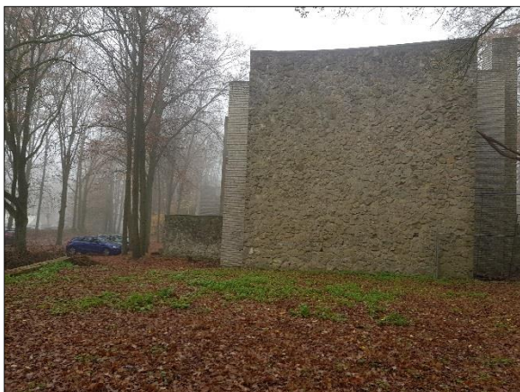
Figuur 8. Achterkant toneelgebouw waar horeca gerealiseerd gaat worden
