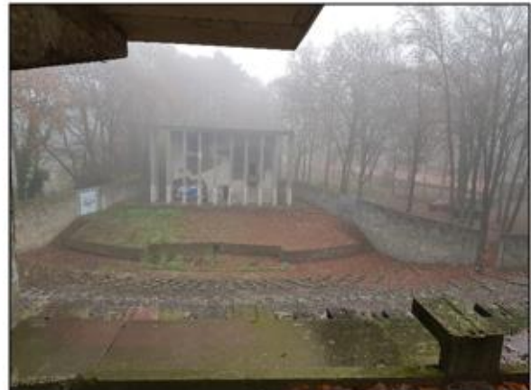
Podium en toneelgebouw gezien vanaf bovenkant regiehuisje
