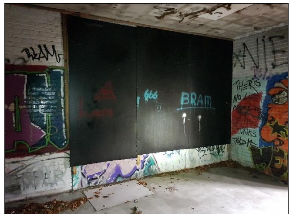
Figuur 9. Binnenzijde toneelgebouw
