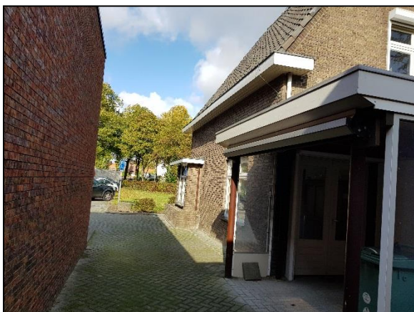
Figuur 6. Het te slopen gebouw vanaf zuiden
