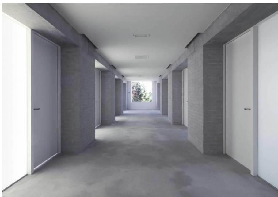
Foto: voorbeeld met slempwerk en prefab beton
