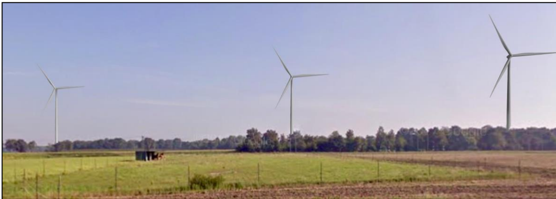
Zicht op de opstelling gezien vanuit het zuiden
