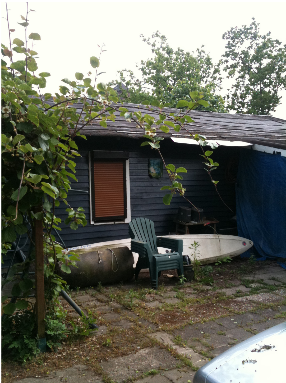
Figuur 7: Foto van het opslaghek met afdak.
