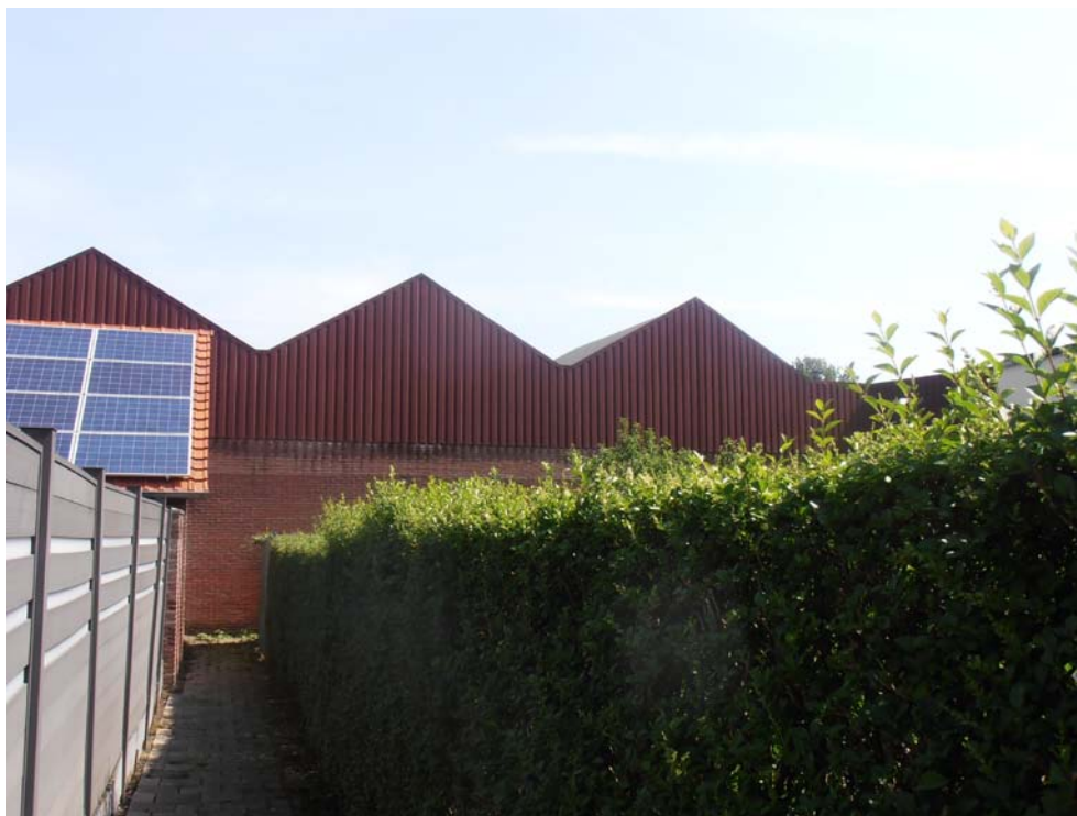
Foto 5: Beeld van de achterzijde van de loods
