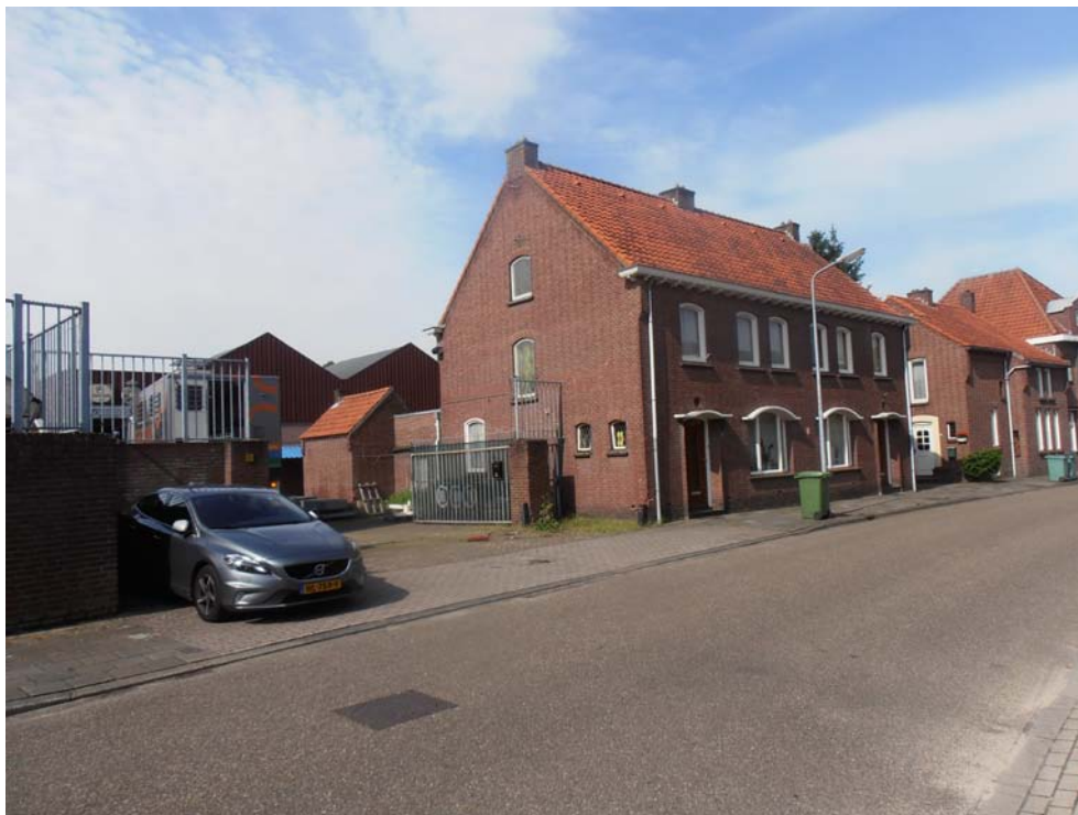
Foto 1: Straatbeeld met ingang Rumoldusstraat 1
