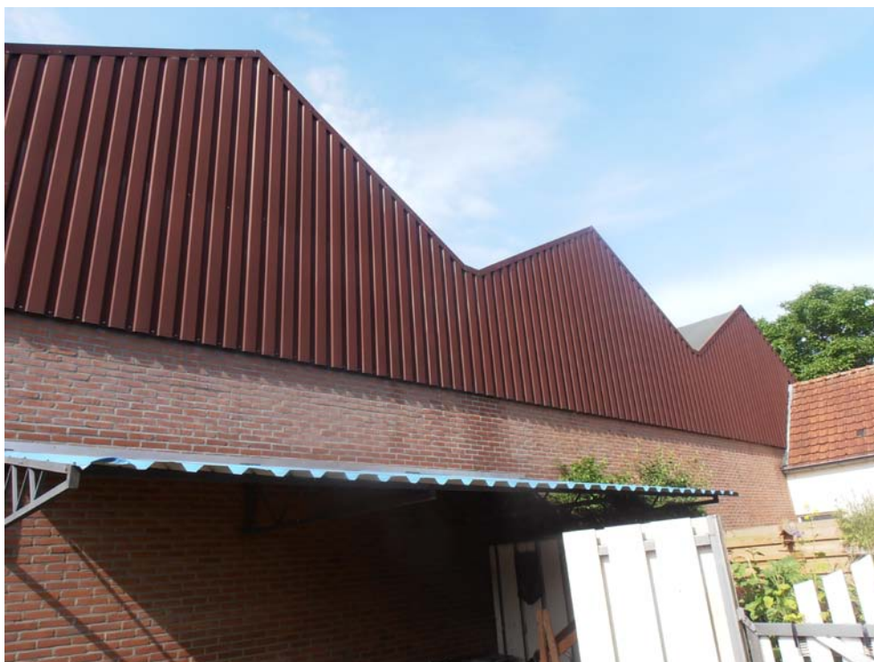
Foto 2: Metalen beplating aan de buitenmuur van de loods
