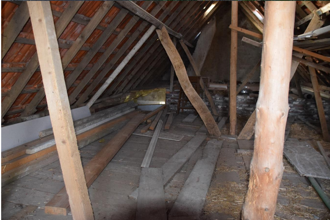
Foto's van gebouw 3 (zuidelijke stal/schuur, blijft behouden) (d.d. 11 april 2022)
