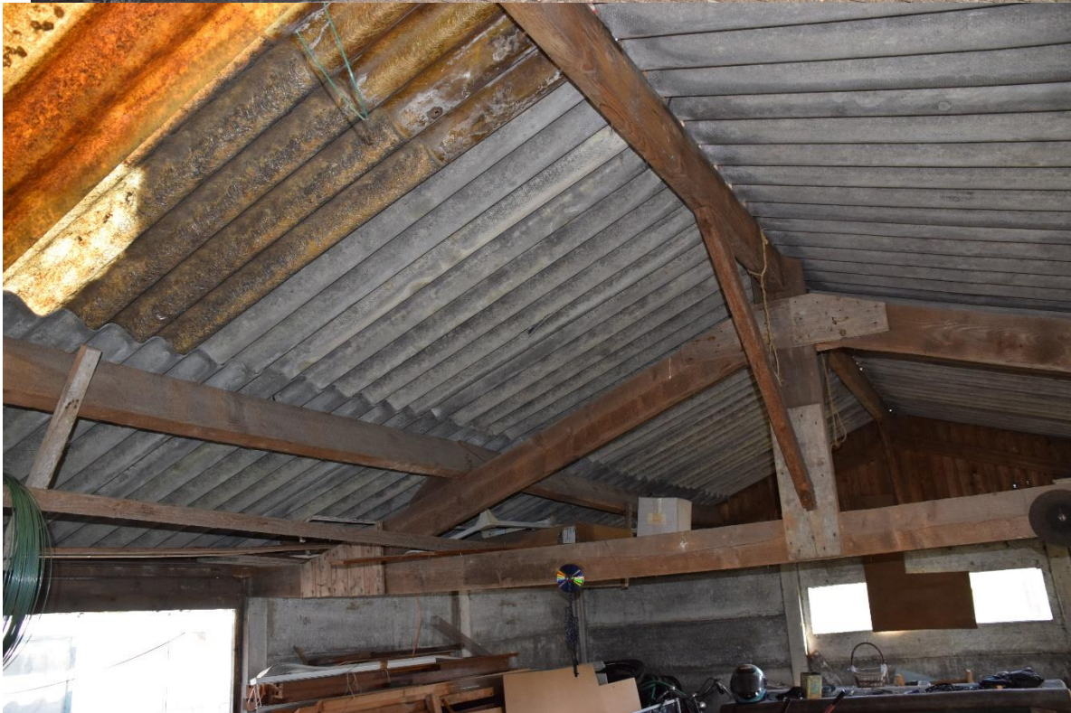
Foto's van gebouw 2 (noordelijke schuur/berging) (d.d. 11 april 2022)
