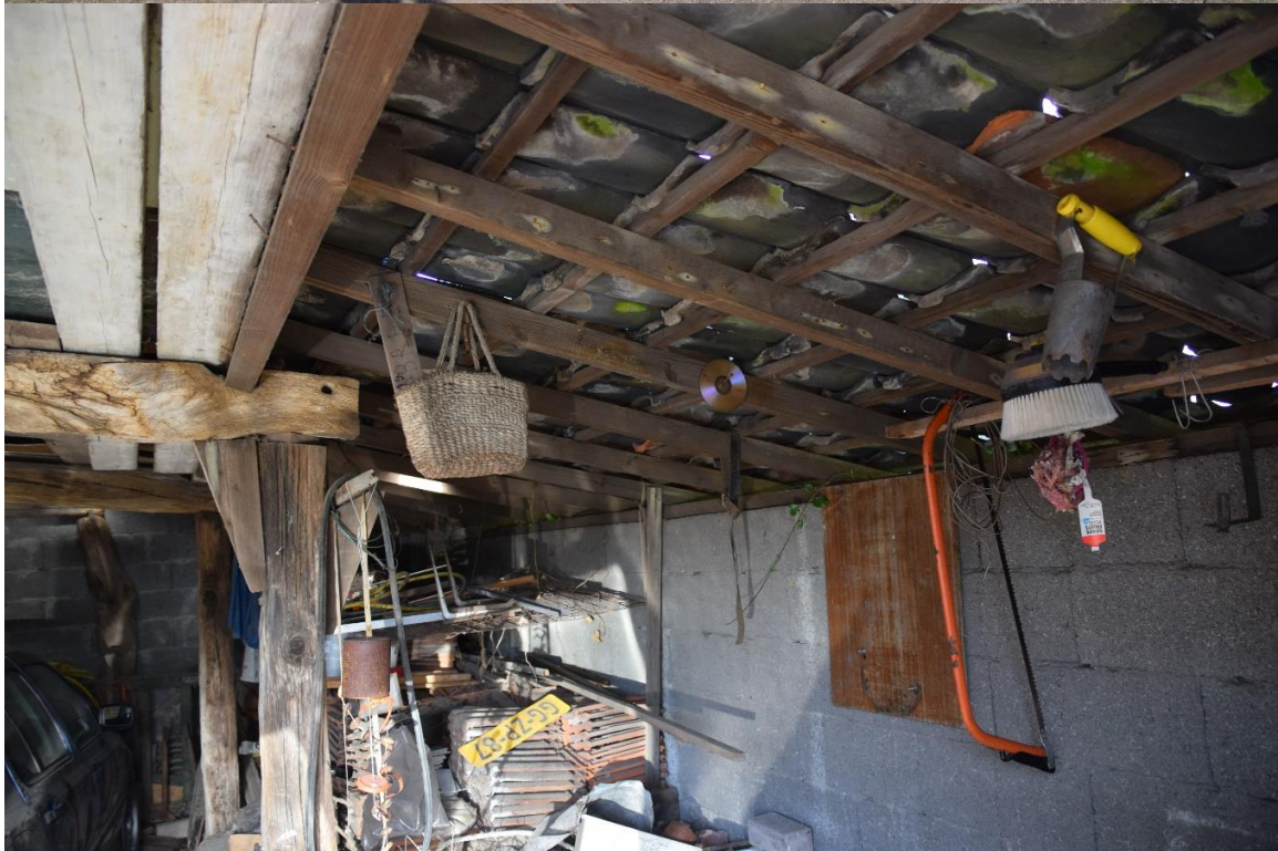
Noordelijke aanbouw van de boerderij (gebouw 4) (d.d. 11 april 2022)
