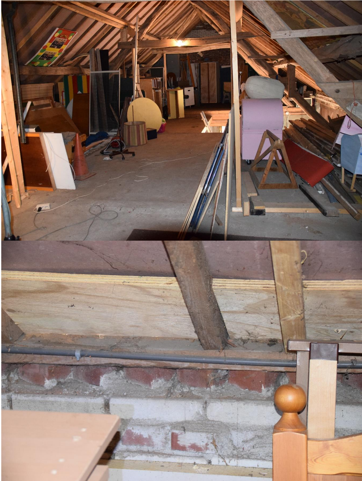
Foto's van de zolderverdieping van het noordelijke deel van de boerderij (d.d. 11 april 2022)
