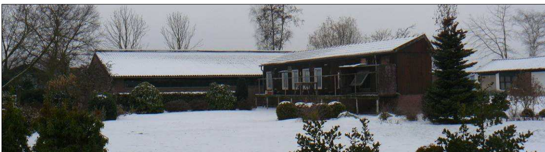
de te slopen bijgebouwen Schonkenweg 6, van links naar rechts: voormalige stal, duivenhok en gara-
