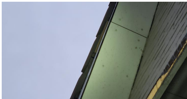
Figuur 5: Gevelpannen en dakrand van de zuidgevel
