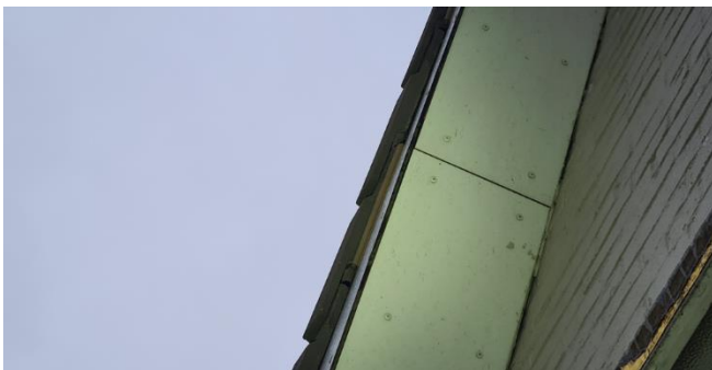
Figuur 7: Gevelpannen en dakrand van de zuidgevel
