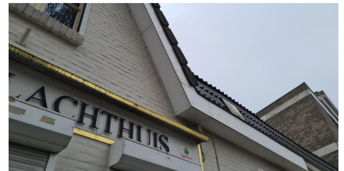
Figuur 9: Dakrand van de noordgevel
