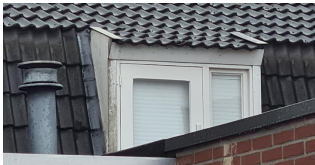
Figuur 8: Dakkapel aan de noordzijde van de woning
