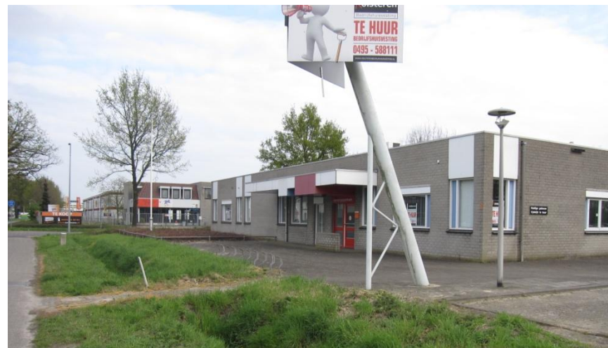
Figuur 10: bestaande bebouwing
