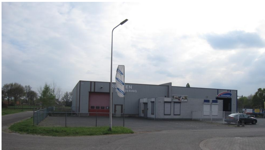
Figuur 9: bestaande bebouwing
