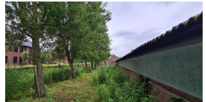
Figuur 6: Pluimveestal en bomen in het oosten van het plangebied
