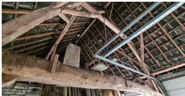
Figuur 8: Binnenzijde van de opstal in het zuiden van het plangebied
