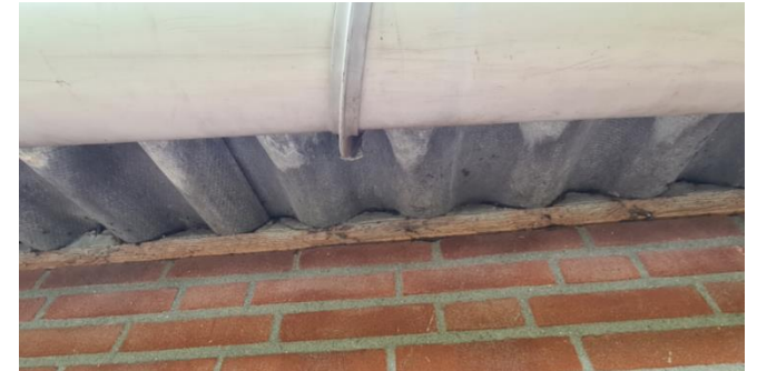
Figuur 5: Dakrand pluimveestallen
