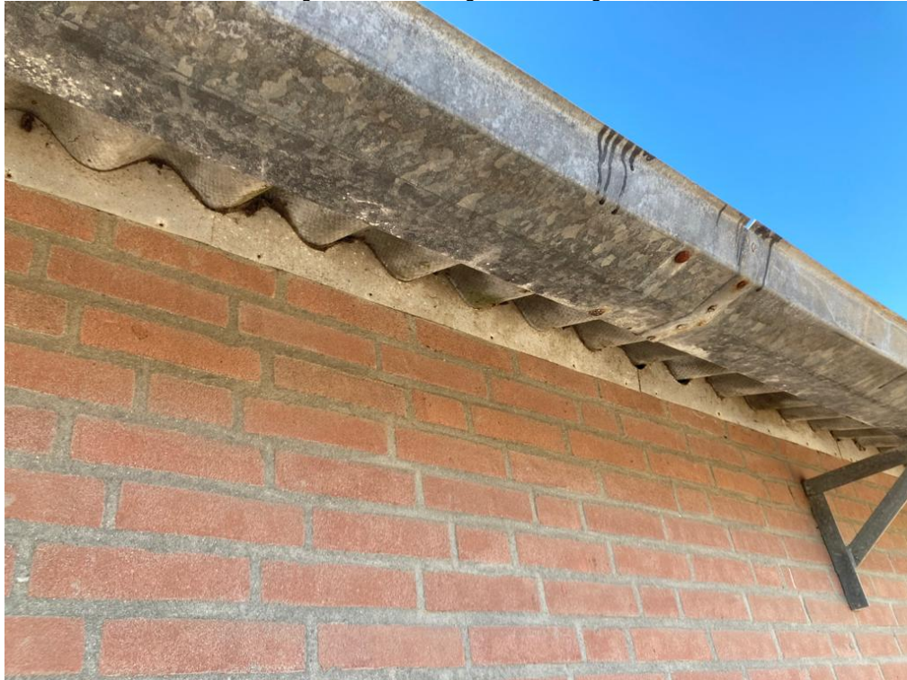
• Afbeelding 19: varkensstallen gesloten met vogelschroot
