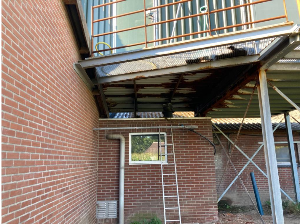
• Afbeelding 11: gebouwen rondom de luchtwasser
