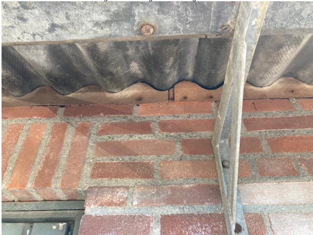
• Afbeelding 5: varkensstal gesloten met vogelschroot
