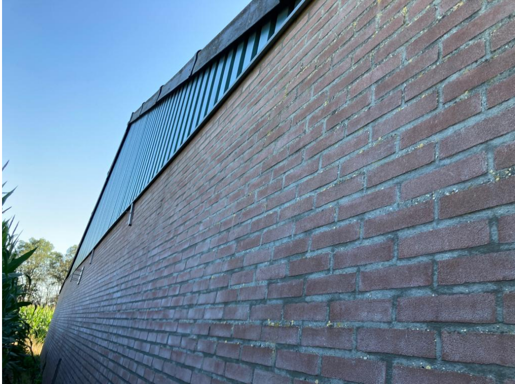
• Afbeelding 13: achtergevel varkensstal
