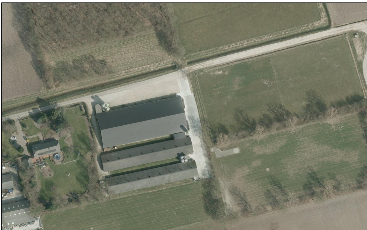
Figuur 1: Luchtfoto huidige situatie
