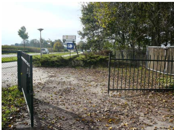
Toegangspoort P-terrein / locatie (rechts)
