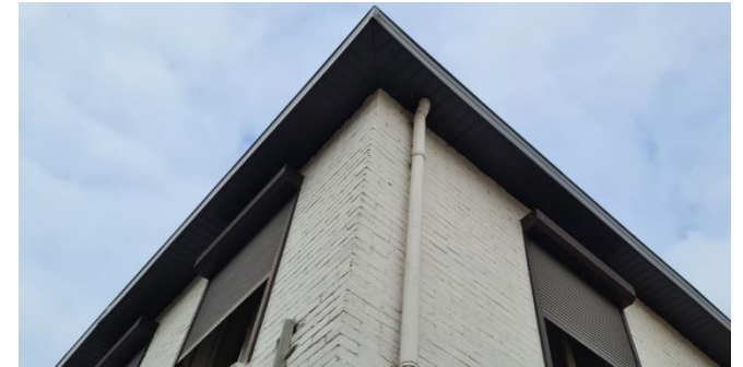
Figuur 5: Dakrand van de woning aan de Kruisstraat
