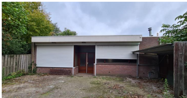
Figuur 8: Bedrijfshal gezien vanuit het westen
