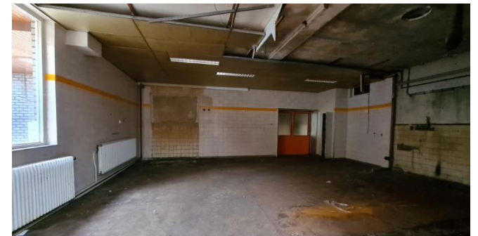
Figuur 6: Binnen aanzicht van de bedrijfshal
