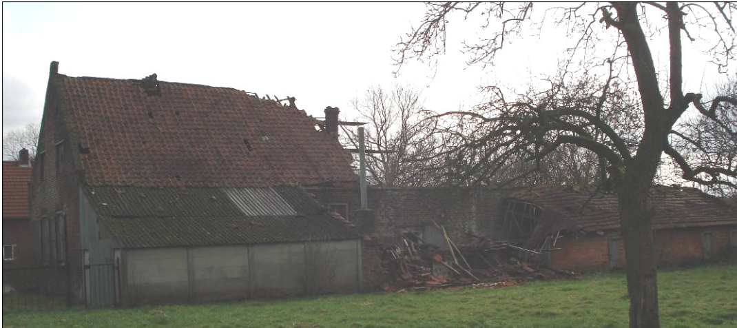
achterzijde bestaande boerderij
