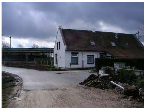
Wederopbouw woning aan kanaal
