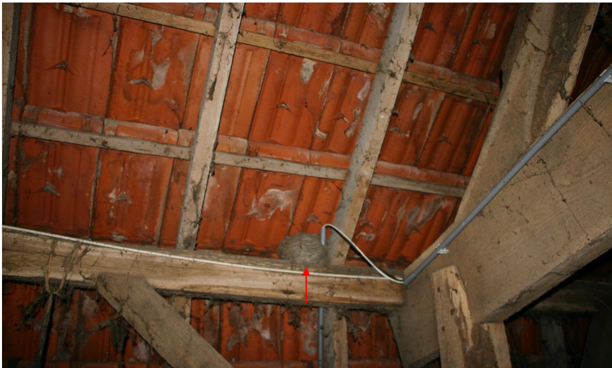
Figuur 4.2.1. Op de zolders zijn geen vleermuizen of uitwerpselen waargenomen. Wel zijn er enkele wespennesten aanwezig (zie rode pijl).
