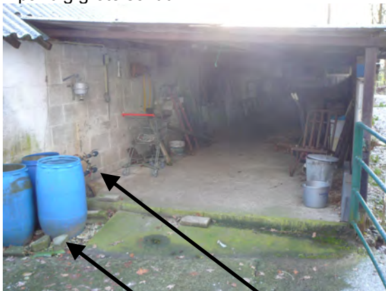
Aanbouw westelijke zijde grote schuur / situering vml. 600 l petroleumtank en grondwateronttrekkingsbron
