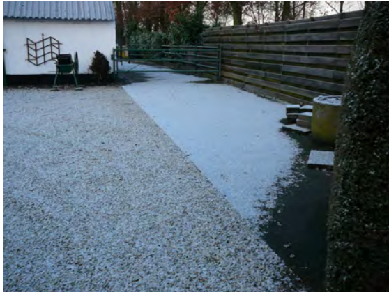
Grindverharding oprit en naastgelegen beton
