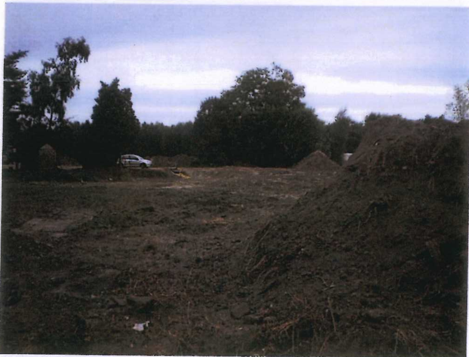
Gesloopte bebouwing (gezien vanaf zuiden, kijkend in westelijk richting)
