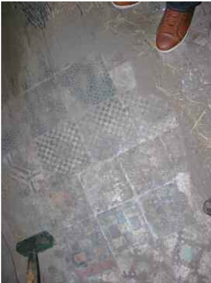
28. De uit restanten samengestelde vloer
