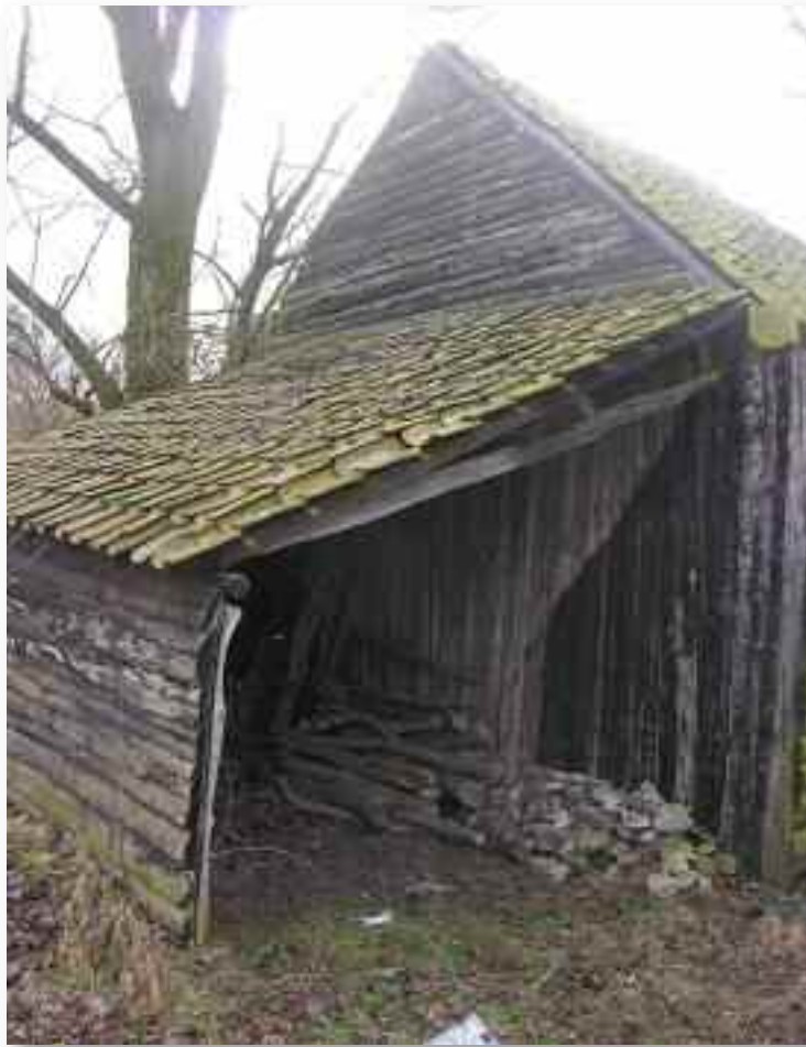
9. Het afdak aan de straat
