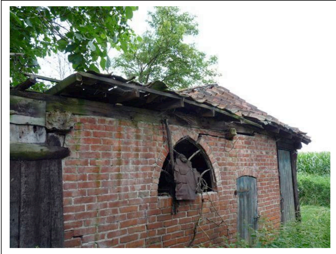
Foto 3. Veeshuur aan oostzijde van de boerderij.
