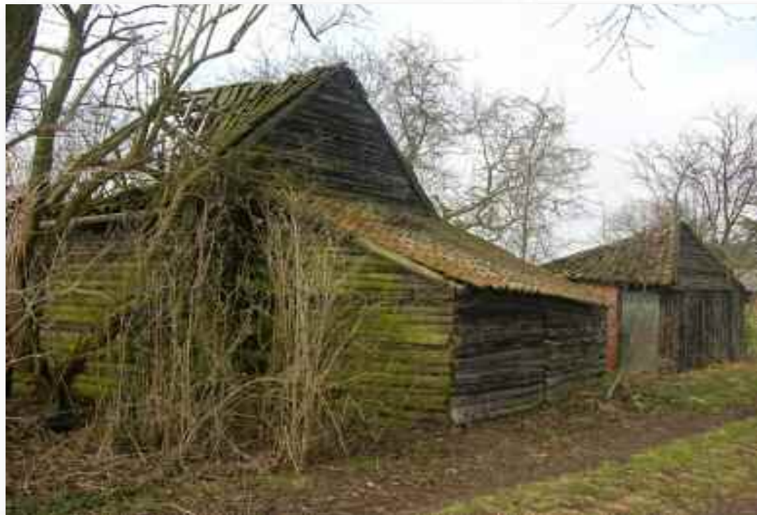
10. De overgang naar de zuidgevel
