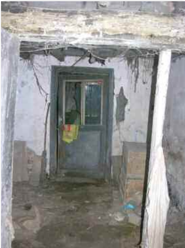
20. Doorkijk vanuit het halletje door de rechter kamer naar de caféruimte
