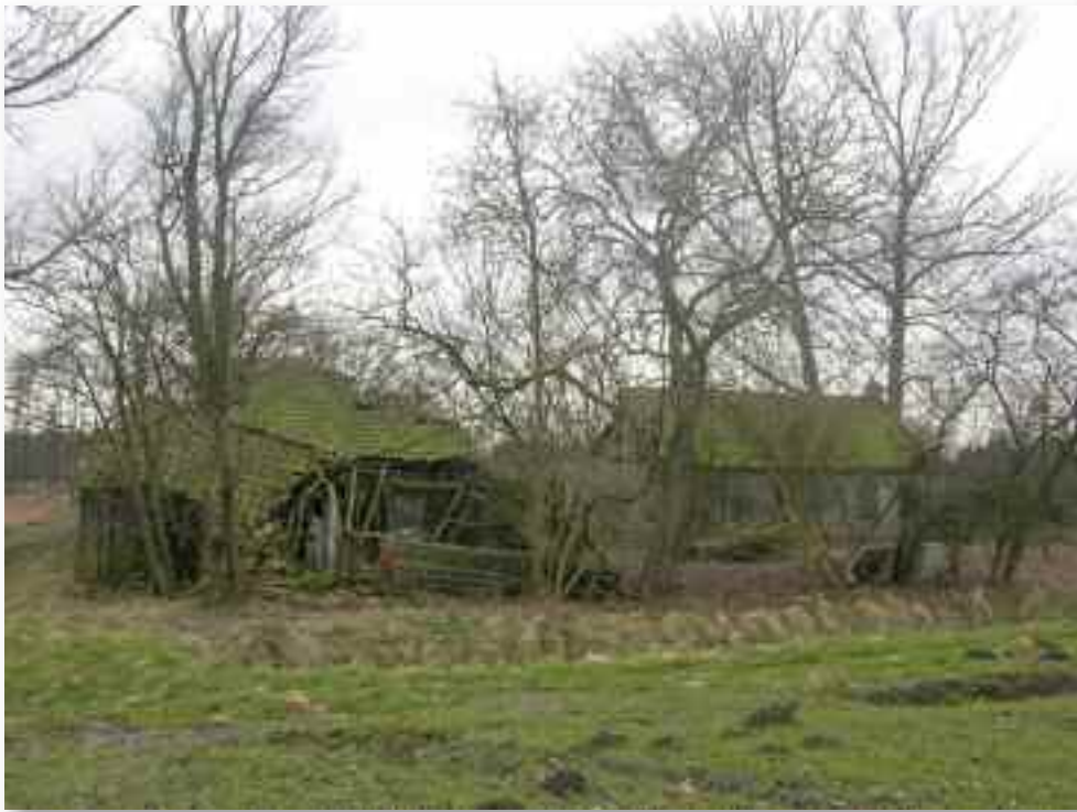
1. De boerderij vanaf de weg met op de voorgrond het bakhuis annex stal
