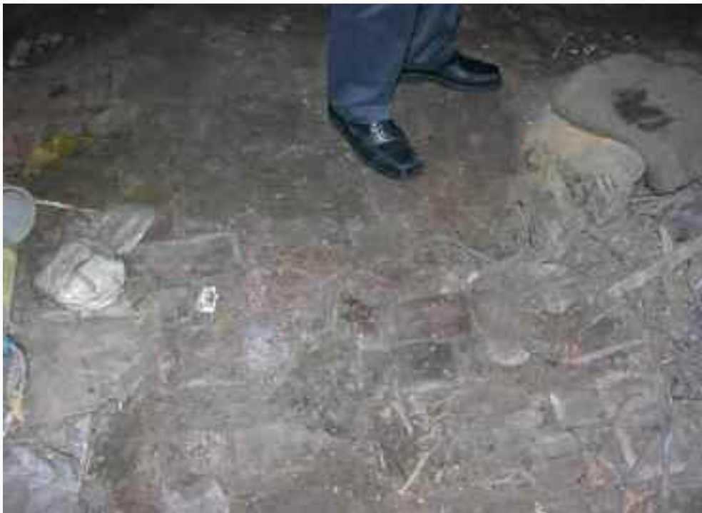
21. De vloer is belegd met rode plavuizen met reparaties in baksteen
