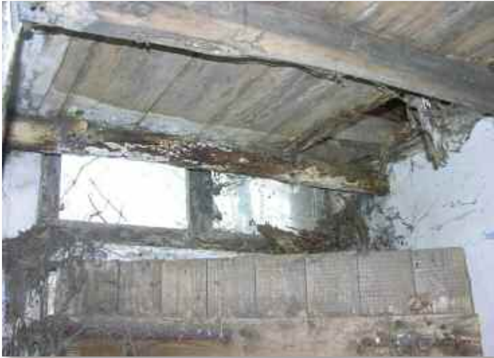
17. Het bovenlicht van de voordeur dat voor het plafond doorloopt
