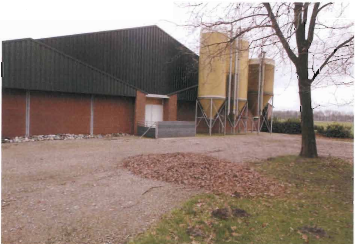
foto 2: aanwezige gebroken puinverharding ten zuidwesten van de meest oostelijk gelegen varkensstal.
