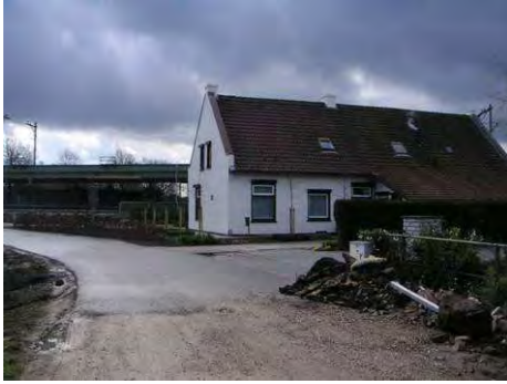
Wederopbouw woning aan kanaal
