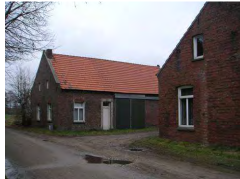
Bebouwing aan de Keentersteeg, oostzijde
