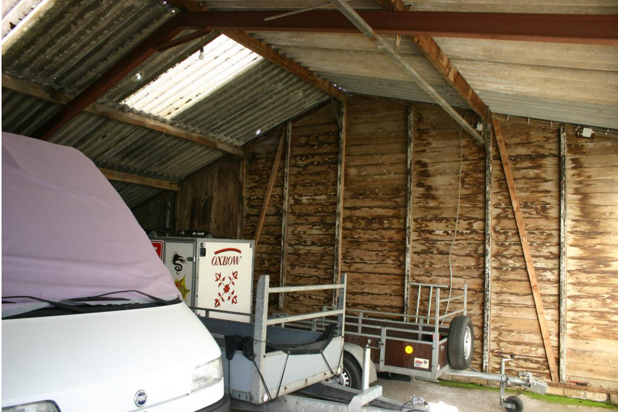
Figuur 4.4.1. De te slopen schuur is volledig enkelwandig.
