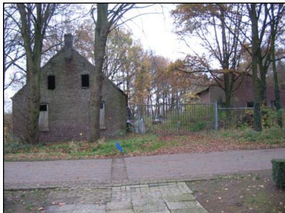
Afb. 8: Voorzijde plangebied te slopen bebouwing
