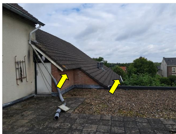
Figuur 4.4 Ruimte tussen de dakgoot en dakpannen (gele pijlen).
