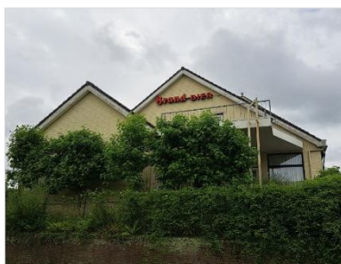
Figuur 2.5 Linker zijgevel, kijkrichting zuid.
