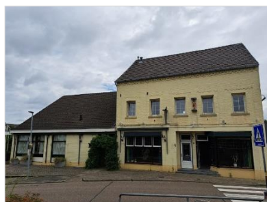
Figuur 2.3 Voorgevel onderzoekslocatie, kijkrichting oost.
