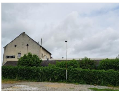
Figuur 2.4 Rechter zijgevel, kijkrichting noord.
