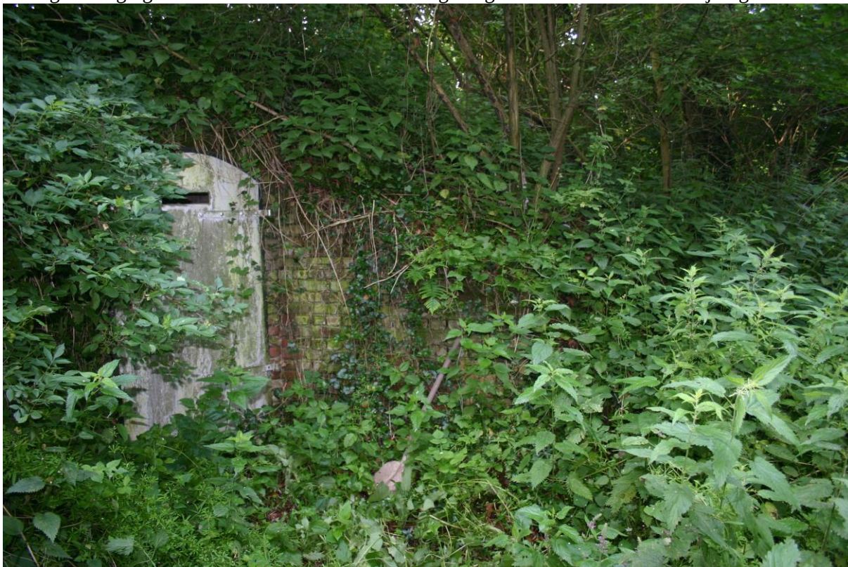
Figuur 3. De ingang van de vleermuiskelder voor het maken van de keermuur
