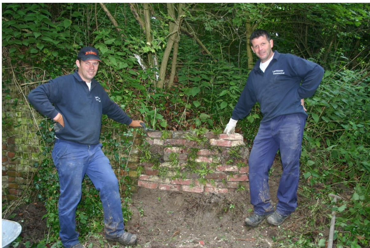
Figuur 4. Cyril Kamps en Ron Custers bij het keermuurtje met steenbreekvarens in aanbouw
