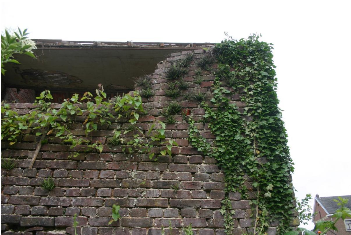
Figuur 2. De steenbreekvarens op de te slopen muur
