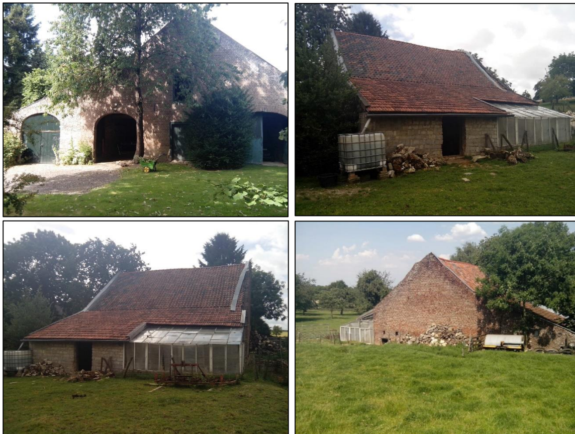
Foto's bestaande situatie
