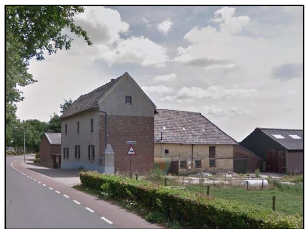
Afbeelding 3. Zijgevel woning en aangebouwd deel.
