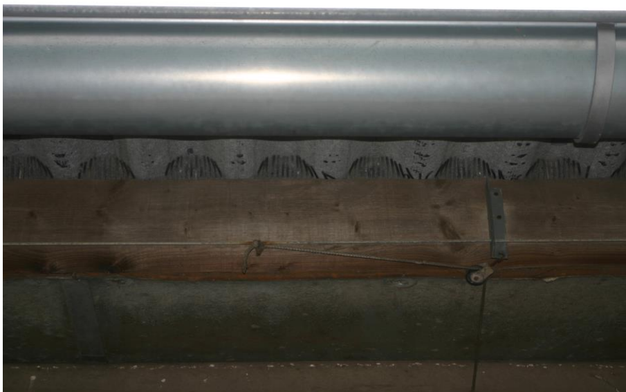
Figuur 4.4.3. Onder de golfplaten van de te slopen stal is vogelschroot aanwezig. Vogelnesten zijn hier zeker afwezig.
