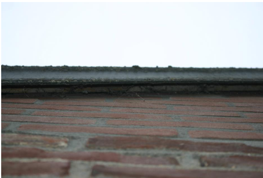
Figuur 4.4.2. De windveer bevindt zich op een houten lat die nauw aansluit op de gevel.
