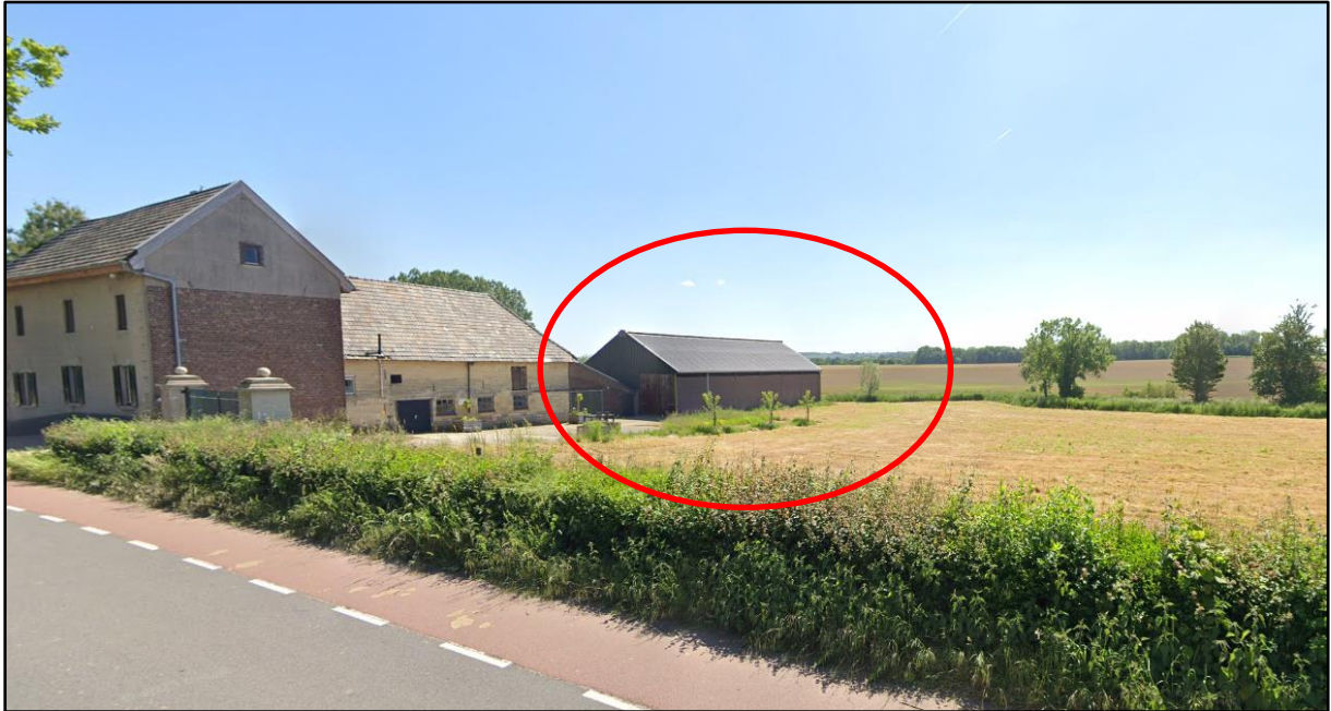
Afbeelding 5: aanzicht straatzijde komende vanuit Klimmen. Rundveestal (omcirkeld) is beeldbepalend, sloop leidt tot kwaliteitsverbetering.
