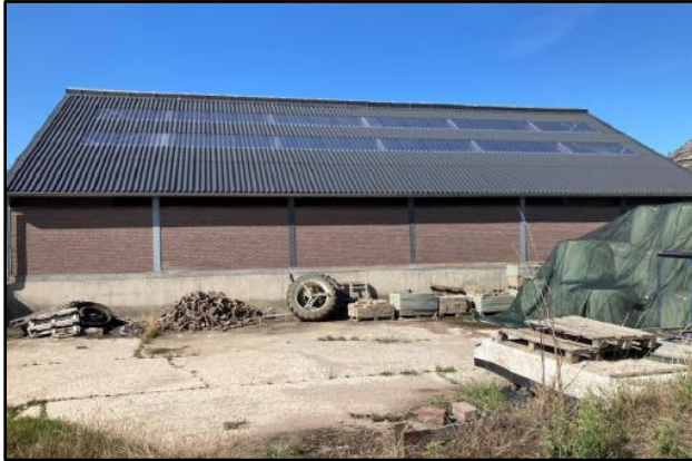
Afbeelding 4: te slopen melkveestal
